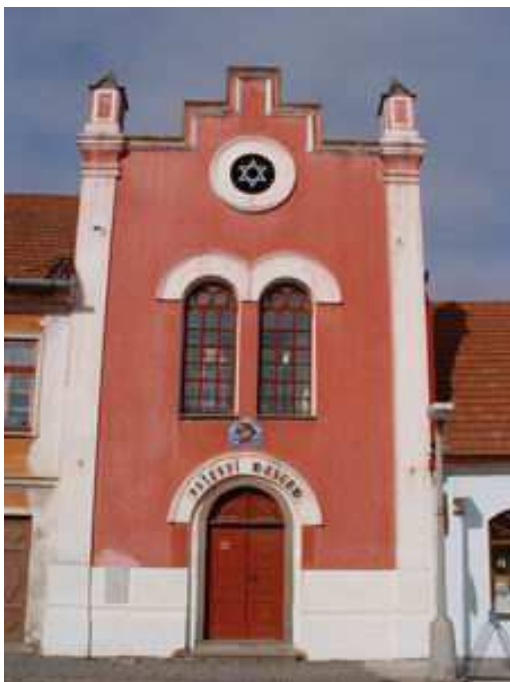
Obr. 6 Synagoga v Bechyni ještě před rekonstrukcí
