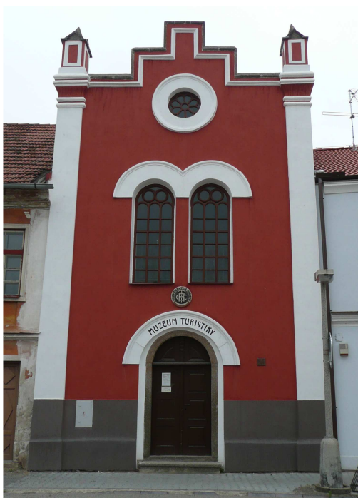
Obr. 7 Muzeum turistiky v budově bývalé synagogy již po rekonstrukci
