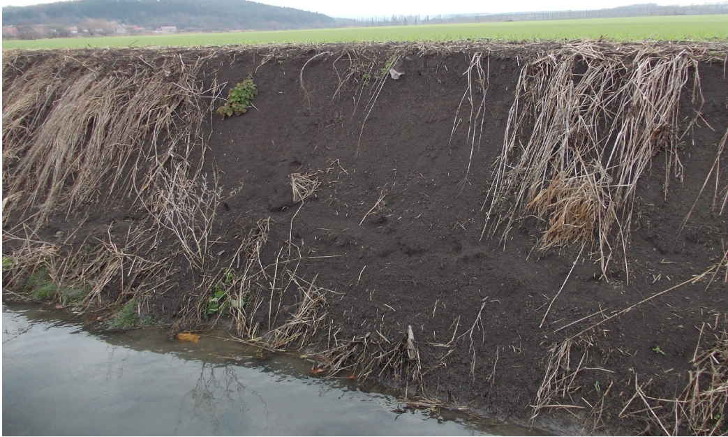
Foto 1: Napřímený regulovaný vodní tok bez břehového porostu v intenzivně zemědělsky využívané krajině s převahou černozemních půd (foto autor).
