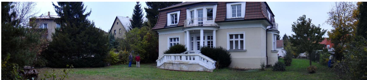
Obrázek 40 – Pohled na hlavní průčelí domu. Dnes tvarované tisy rámují schodiště vedoucí ze zahrady do domu.
