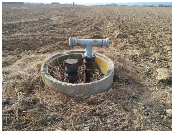
Obrázok č. 13 Napájacia T prípojka
