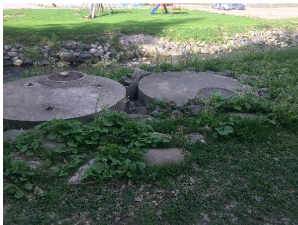
Obr. 17 Zdroj vody pro zasněžování v areálu Kouty nad Desnou (Habermann, 2018)
