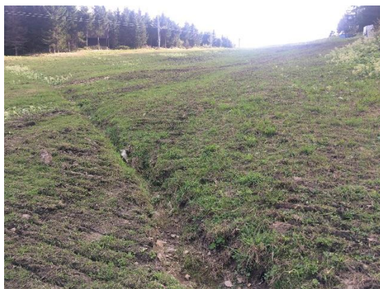
Obr. 27 Protierozní opatření ve ski areálu Červenohorské sedlo (Habermann, 2018)
