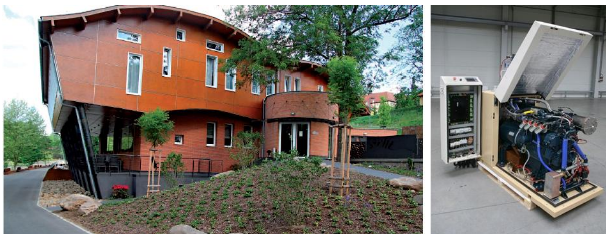
Obr. 2 Použití kogenerační jednotky v hotelu [2]
