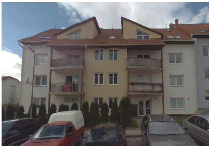
obr. č. 29 - bytový dům s jednotkou č. 10 (ulice Hloužkova, Moravské Budějovice) [9]
