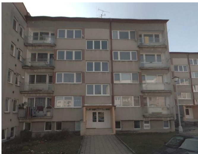
obr. č. 15 - bytový dům s jednotkou č. 3 (ulice U Víta, Jemnice) [9]
