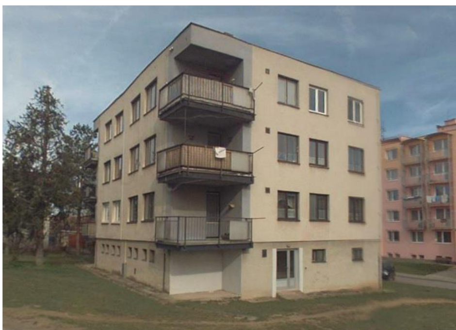
obr. č. 23 - bytový dům s jednotkou č. 7 (ulice Gymnazijní, Moravské Budějovice) [9]
