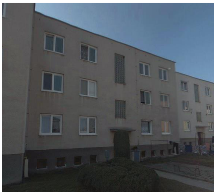
obr. č. 11 – bytový dům s jednotkou č.1 (ulice U Víta, Jemnice) [9]
