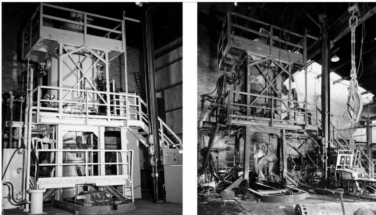
Obr. 10 Fotografie nehody VAR pece před a po (rok 1955) [24]
