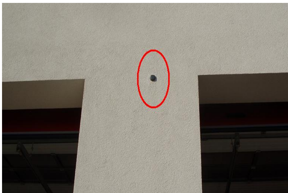
Obr. 9: Umístění přijímací antény šířiče GPS signálu na venkovní zdi garáží.
