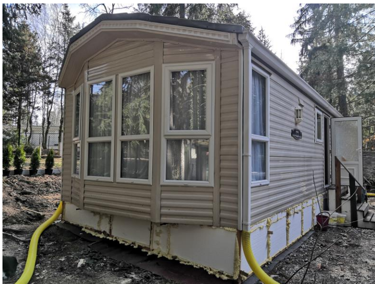
Obr. 7 Mobilní dům usazený na ocelových stojinách a dodatečně dodělaná difúzně uzavřená podezdívka z dřevěného rámu a XPS, uzavřená metoda CS (vlastní foto)
