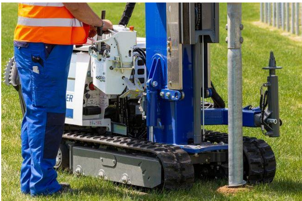
Příloha č. 9a Realizace zemních vrtů – vrtání (KRINNER©2021)
