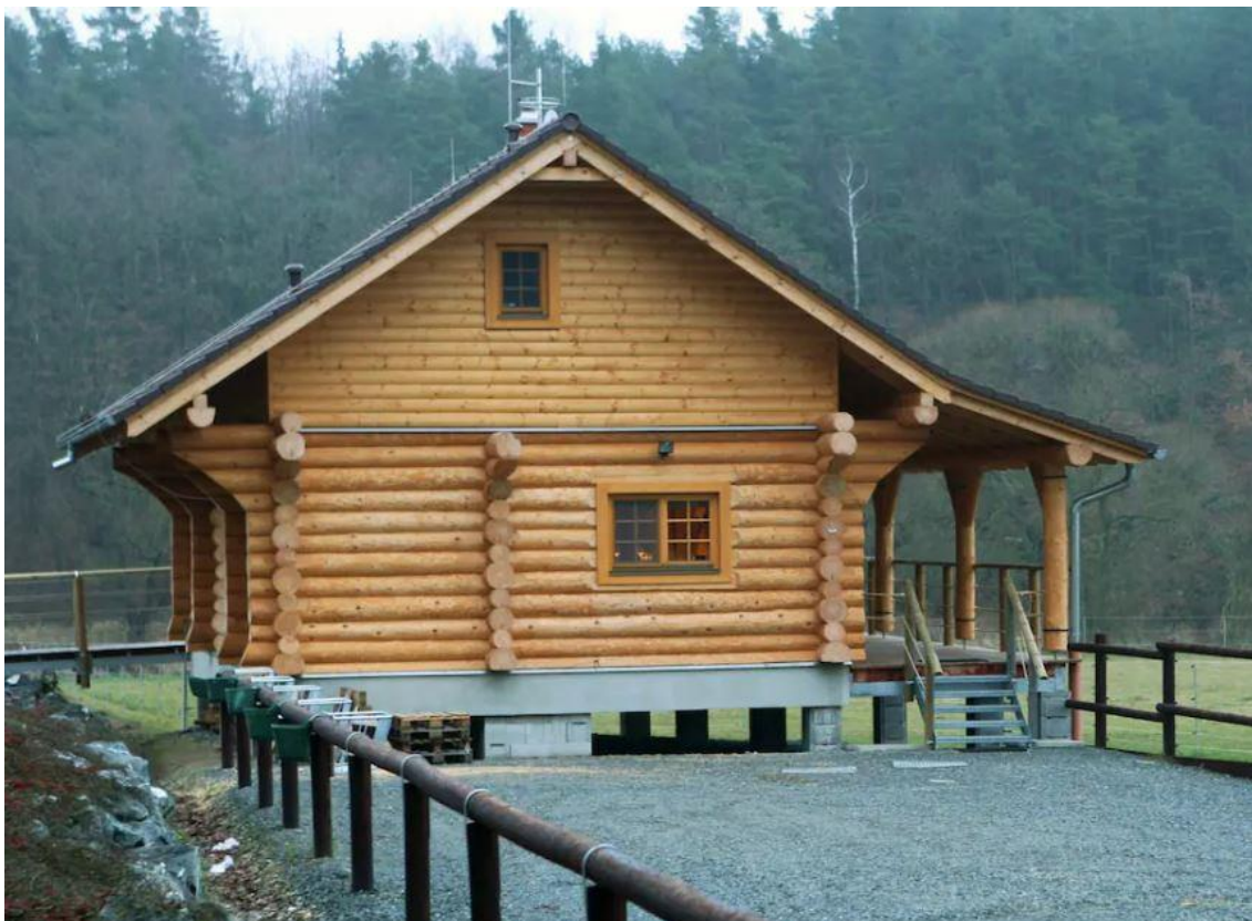
Příloha č. 11 Srub založen otevřenou metodou CS na betonovém trámu (Drachovský 2022)
