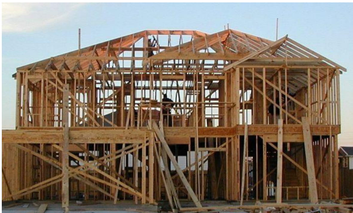
Obr. 31 Rámová dřevostavba realizovaná pomocí staveništní montáže (Jiříček 2012)
