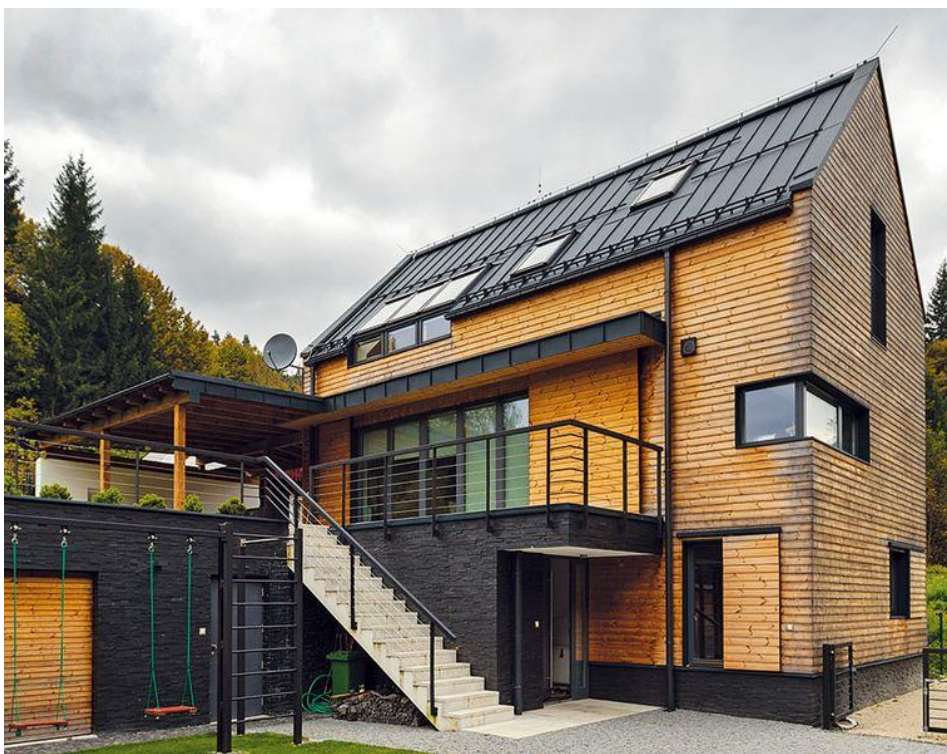
Příloha č. 30 Příklad konstrukčně nevhodného řešení sedlové střechy bez přesahu, konstrukční difúzně uzavřený systém: zdivo Heluz, krytina: falcový hliníkový plech, obložení dřevo ThermoWood, energetický standart: nízkoenergetická stavba (Veselský 2017)
