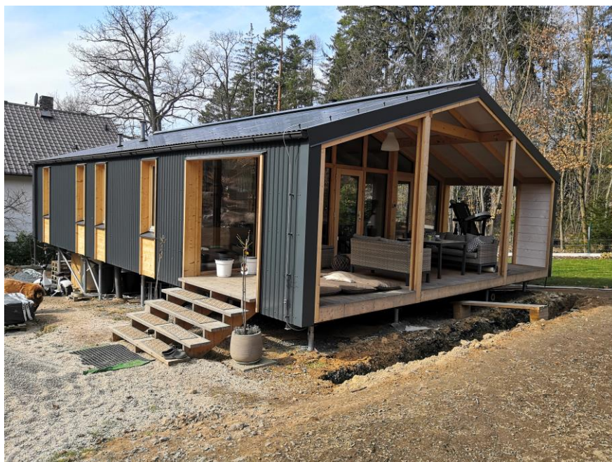
Obr. 8 Dřevostavba postavená otevřenou metodou CS, uložená na ocelovém roštu a na zemních vrutech, včetně zavětrování (vlastní foto)
