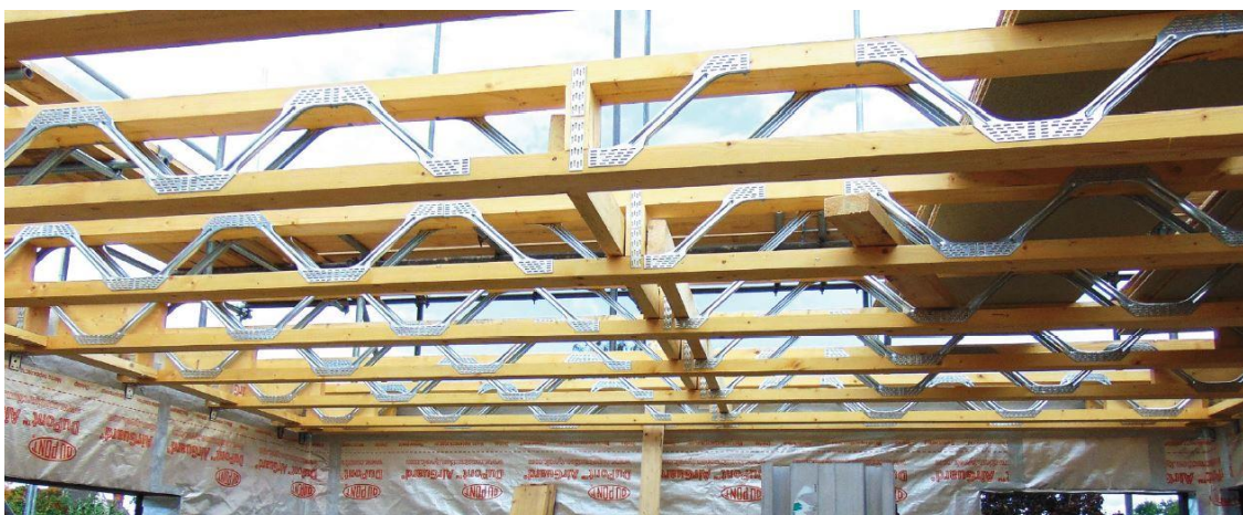
Obr. 24 Ukázka Posi-Joist stropního nosníku včetně zavětrování (MITEK(7)©2022)
