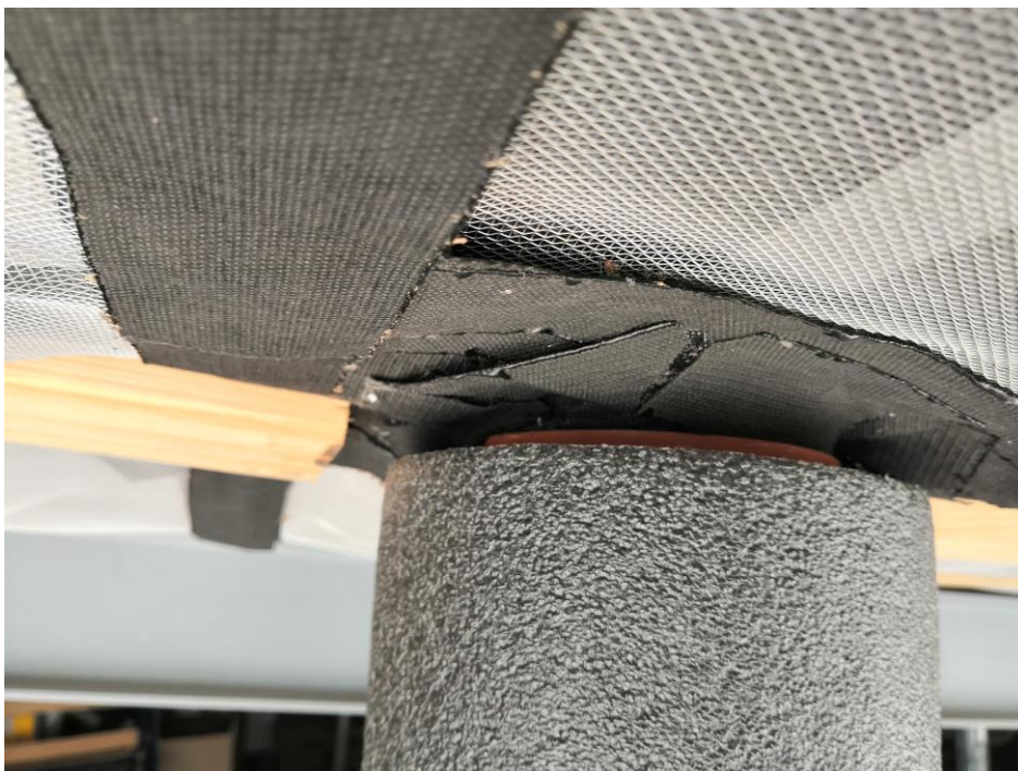
Příloha č. 10 Otevřená metoda CS, vstup kanalizace skrz podlahový rošt, detail (vlastní foto)
