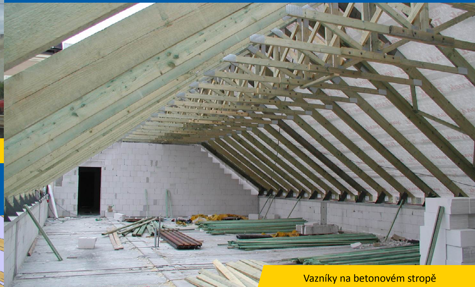
Montáž klasického podkrovního vazníku
