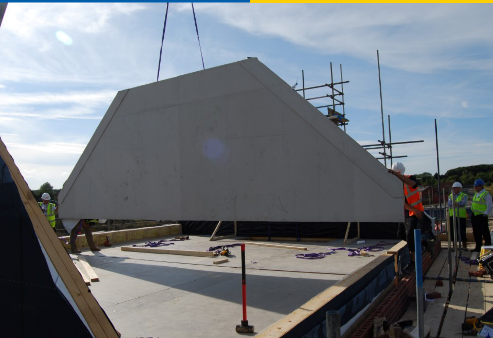
Montáž štítových stěn
