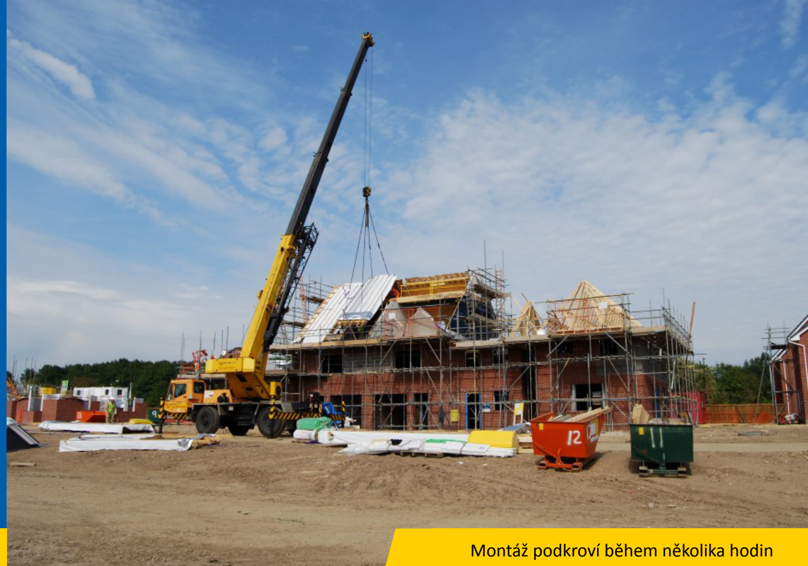
Sestavení podkroví z předpřipravených krokevních panelů
