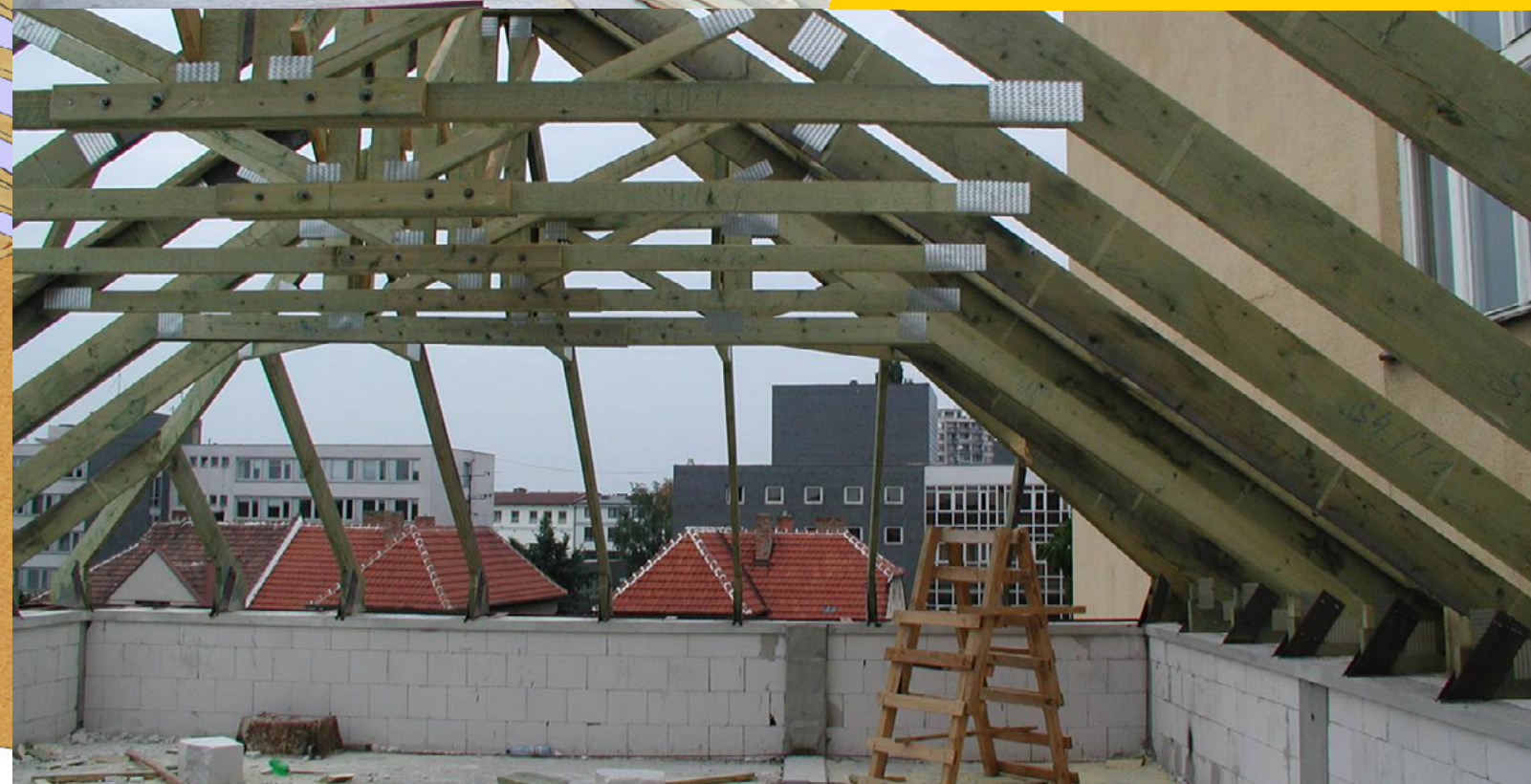
Vazníky na betonovém stropě
