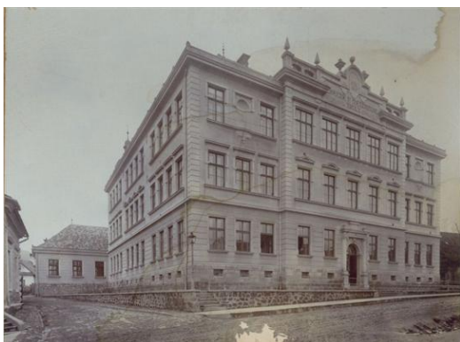
Nová budova měšťanské školy z roku 1907. Měšťanská škola byla ve VK zřízena roku 1872.
