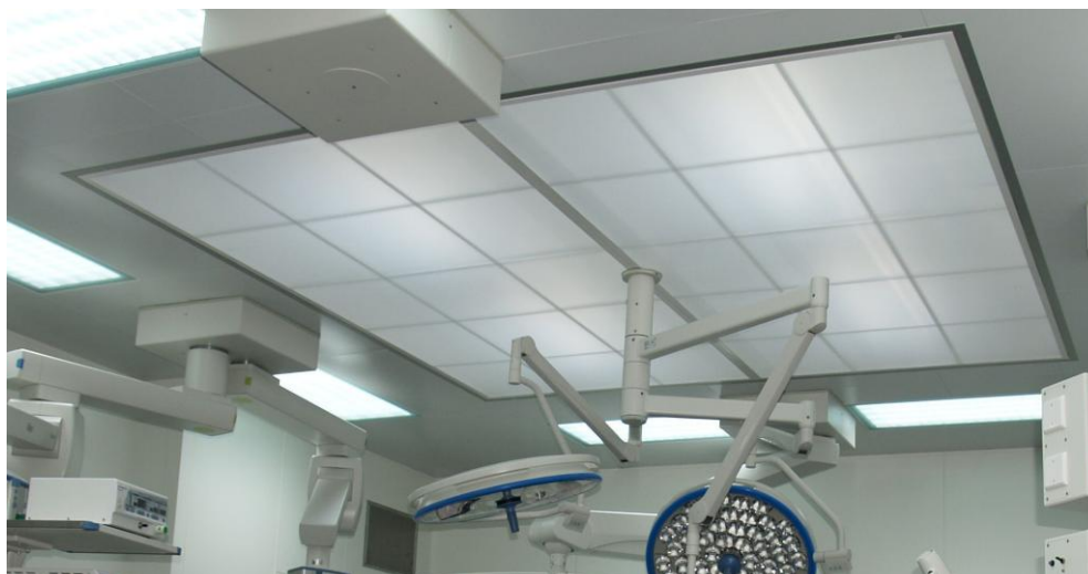
Obr. 2.0 Laminární strop na OS [12]
