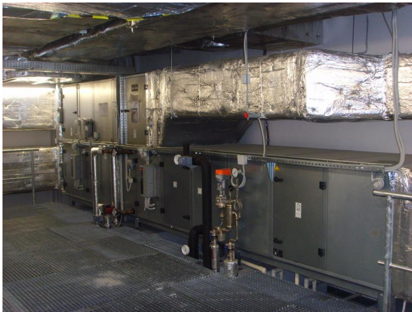
Obr. 2.3 VZT jednotka v hygienickém provedení
