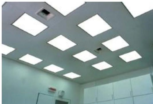
Obr. 2.5 Panelový strop ČP [13]
