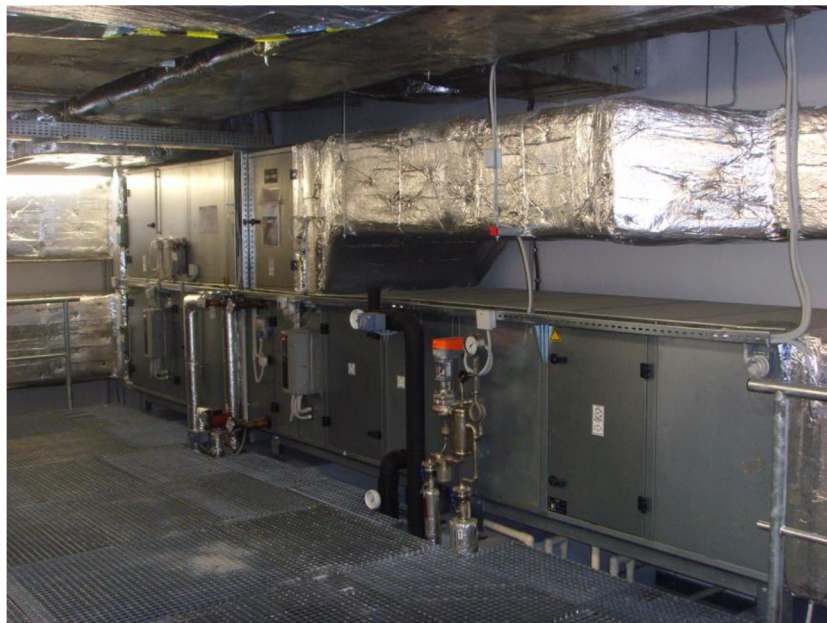
Obr. 2.3 VZT jednotka v hygienickém provedení
