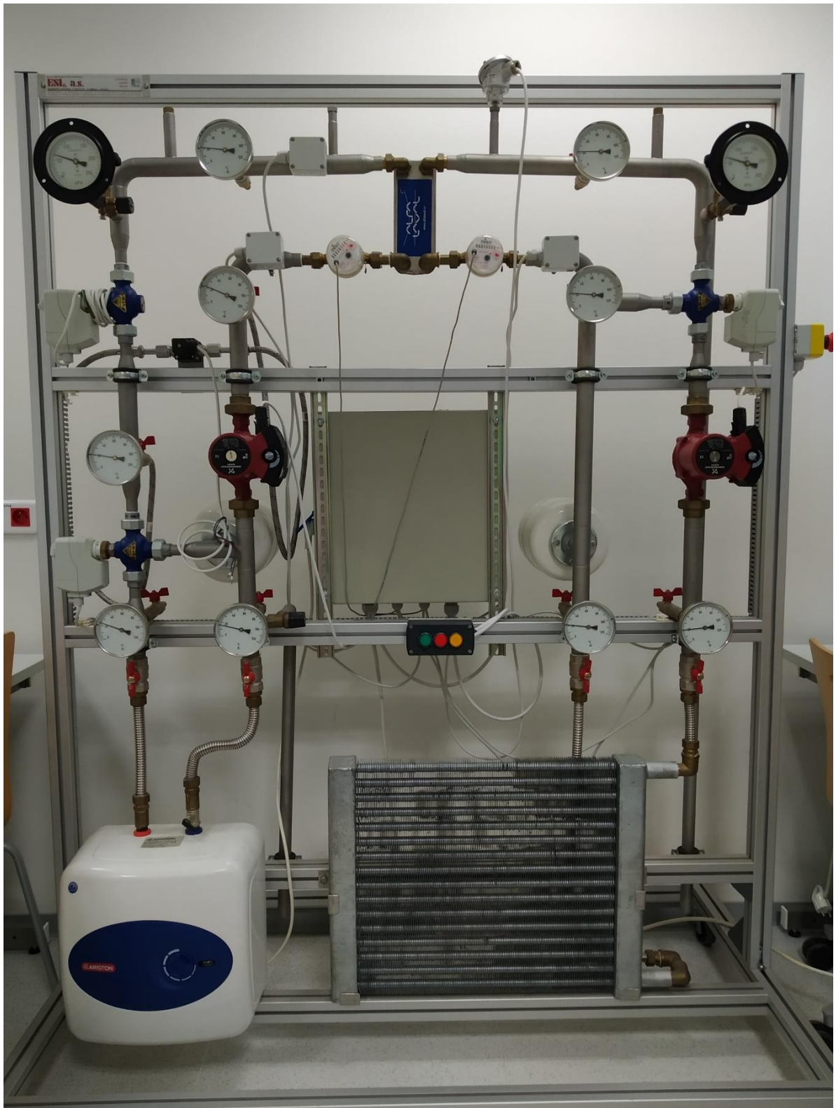
Obrázek 1.3 Měřící stanice s tepelným výměníkem
