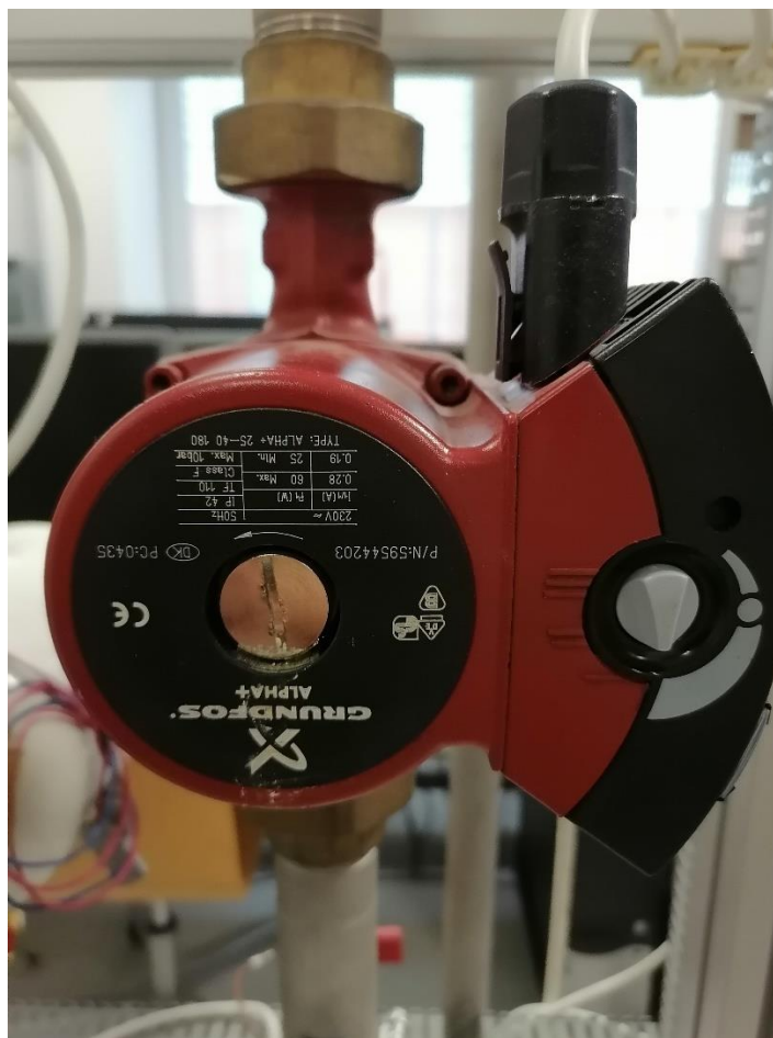
Obrázek 1.4 Čerpadlo pohánějící vodu ve stanici
