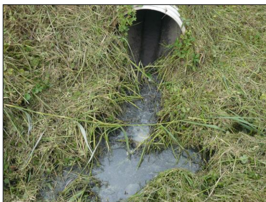
Obr. č. 57: Výpust, Srbská strouha (Dvořák, 2018)
