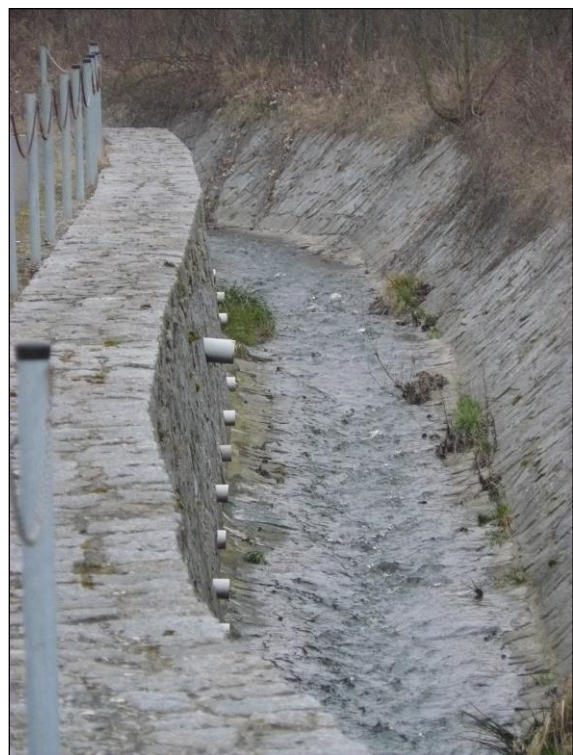
Obr. č. 100: Výpustě do vodního toku (Dvořáková, 2018)
