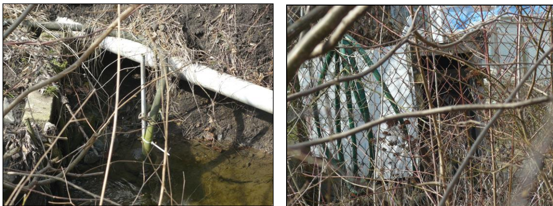
Obr. č. 70 a č. 71: Čerpání vody z vodního toku pomocí technického zařízení (Dvořáková, 2018)
