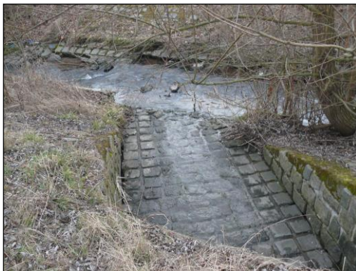
Obr. č. 101: Odvodnění z polí (Dvořáková, 2018)
