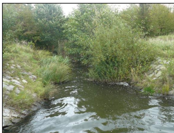
Obr. č. 72: Odtok z nádrže Modlany (Dvořáková, 2017)
