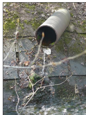
Obr. č. 94: Výpust' do toku (Dvořáková, 2018)
