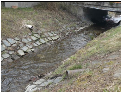
Obr. č. 99: Výpustě do toku (Dvořáková, 2018)
