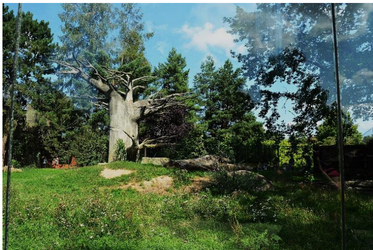
Obr. 40: Dominanta výběhu – betonový strom baobab
