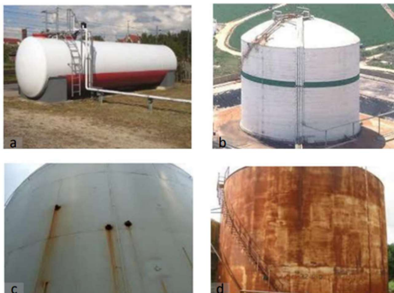
Obr. 13 – Vizuální kontrola reálného stavu zařízení [15]
