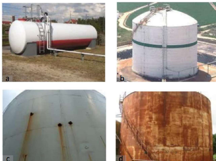
Obr. 13 – Vizuální kontrola reálného stavu zařízení [15]
