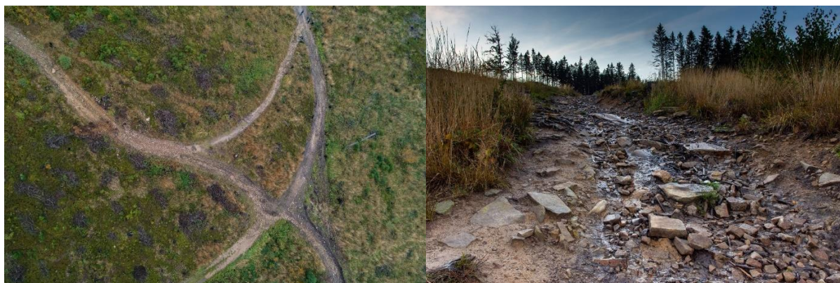
Obr. 7 a 8 – Holé zerodované těžební linky, zdroj: Voda pro les, voda pro lidi 2020
