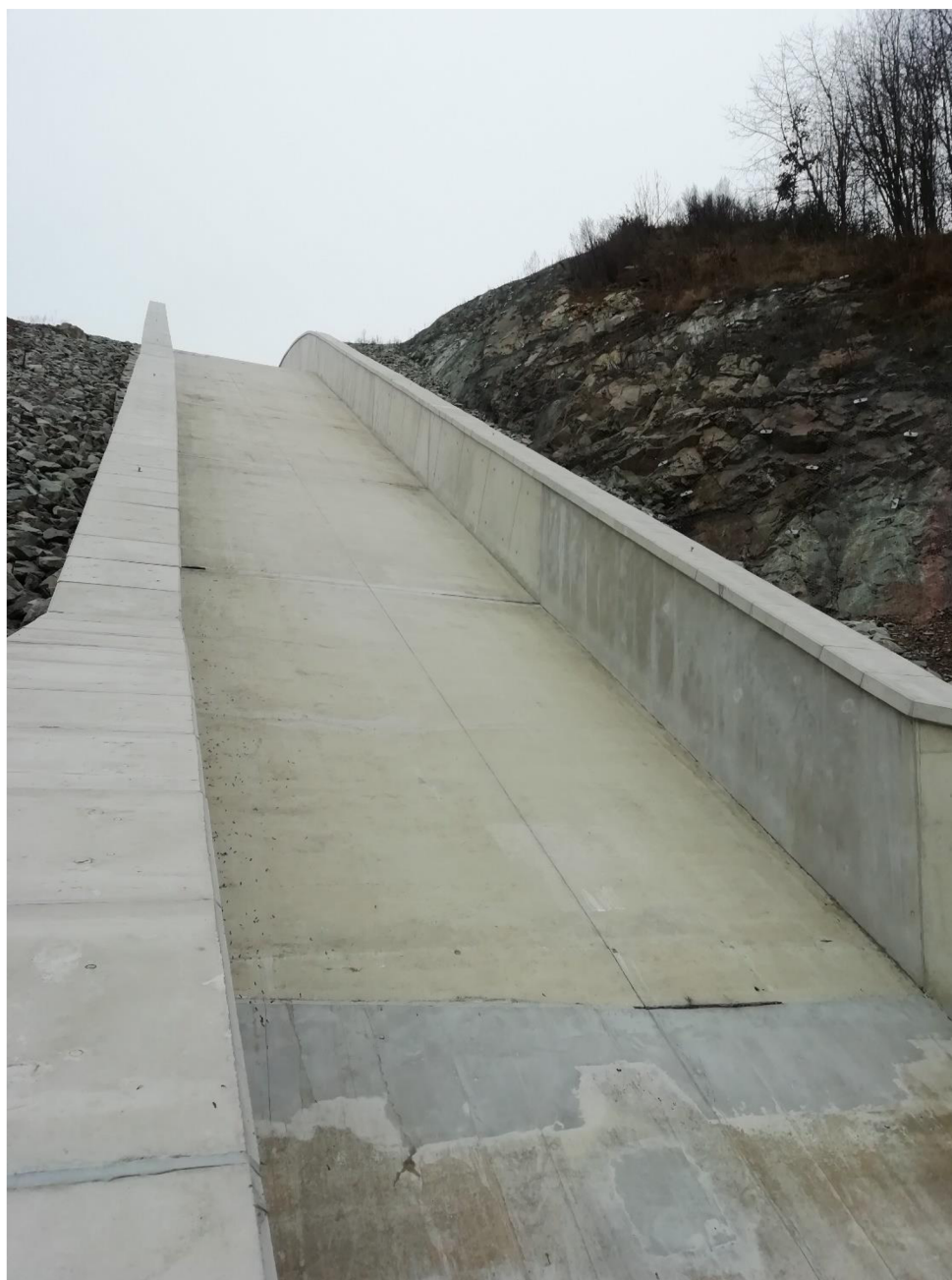
Obrázek 19: Skluz bezpečnostního objektu VD Boskovice [24]
