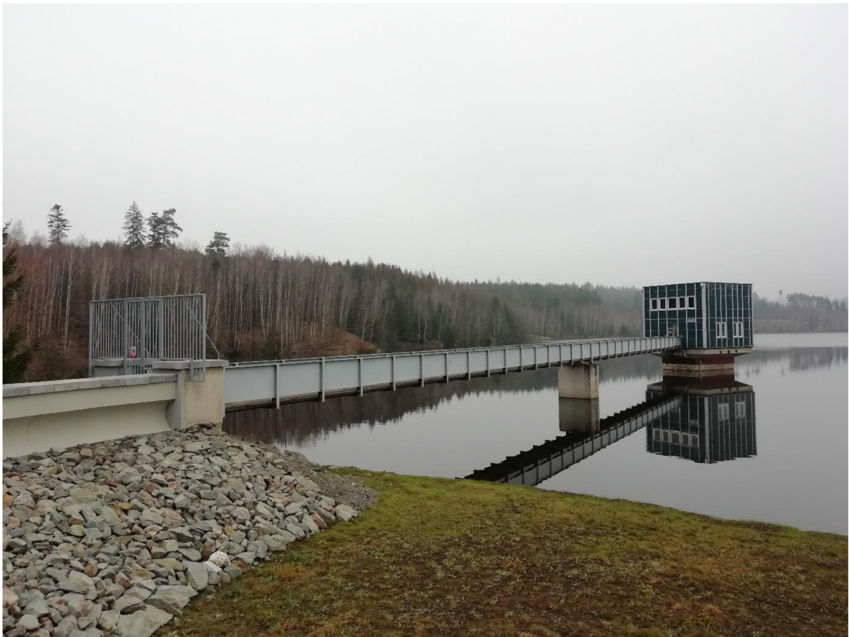
Obrázek 17: Odběrná věž VD Boskovice [24]
