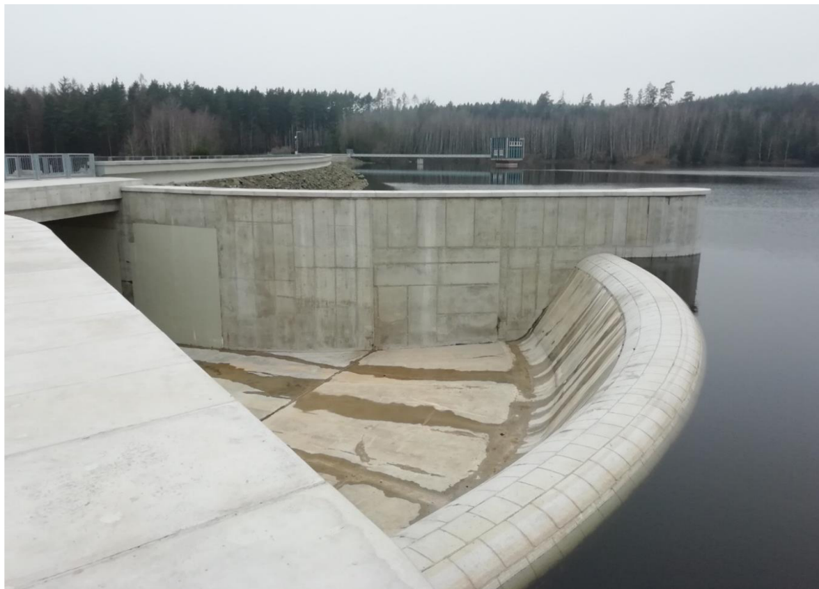
Obrázek 18: Kašnový čelní bezpečnostní přeliv [24]
