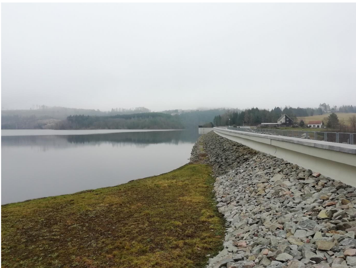
Obrázek 16: Návodní svah VD Boskovice [24]
