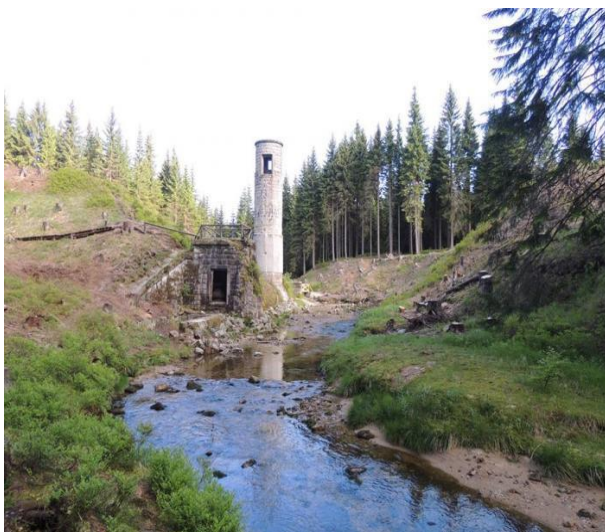
Obr. č. 28: Bílá Desná a Protržená přehrada.
