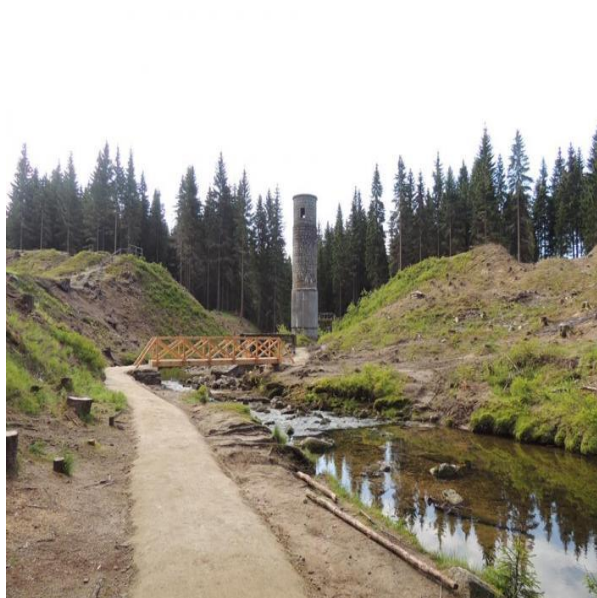
Obr. č. 18: Nově postavená lávka.
