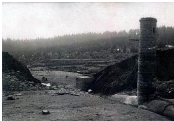
Obr. č. 13: Hráz po protržení.
