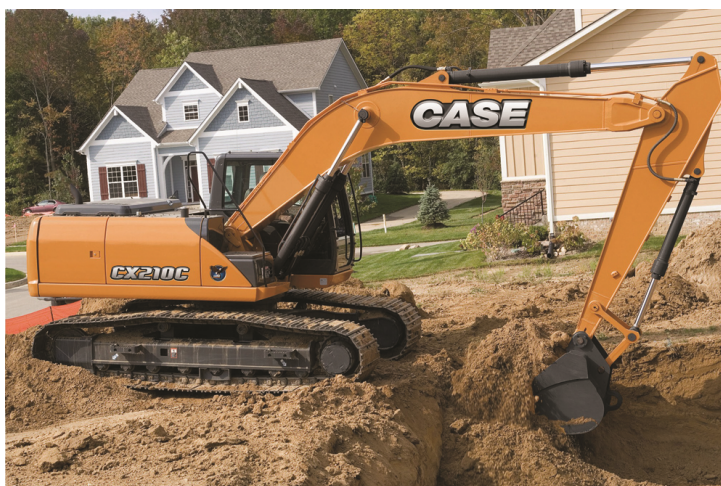
Obr. 4 - Rypadlo s pásovým podvozkem [23]
