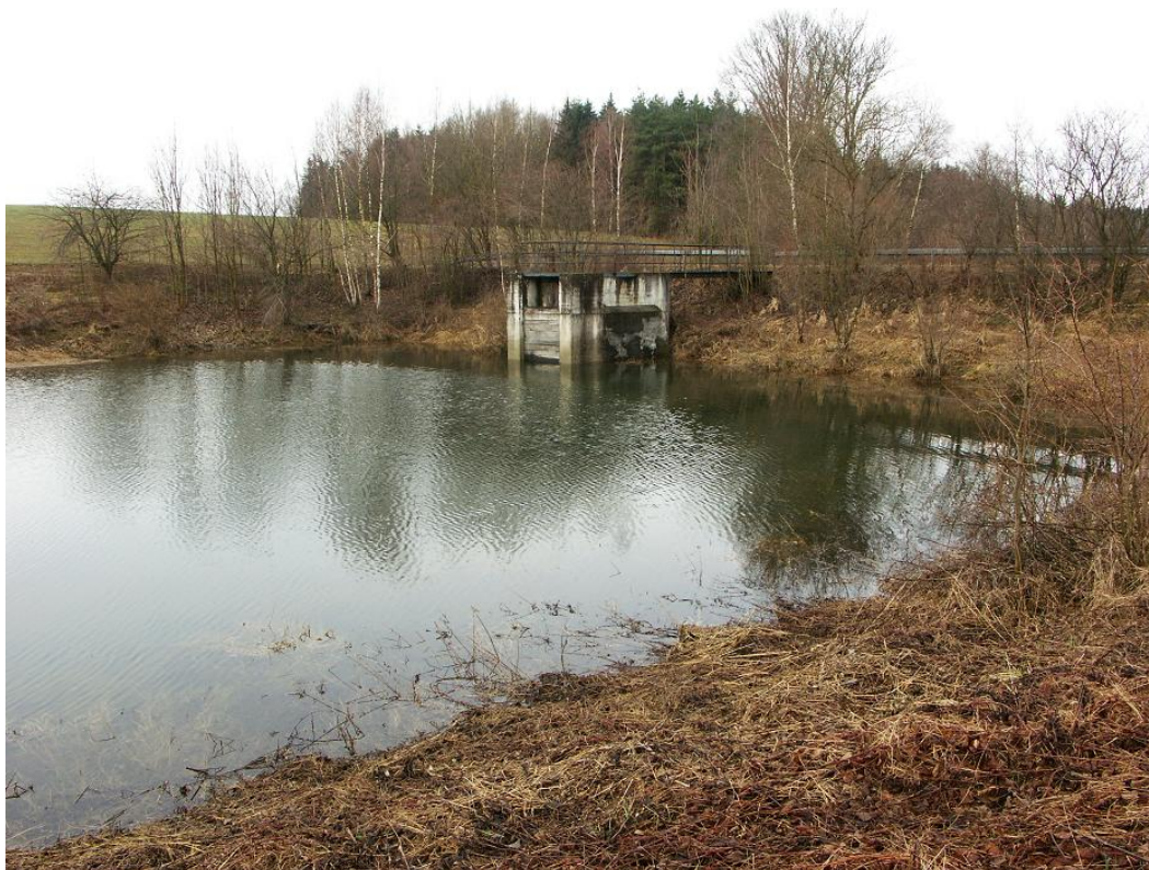
Příloha č. 7: Suchá nádrž č. 1 na Třebovce
