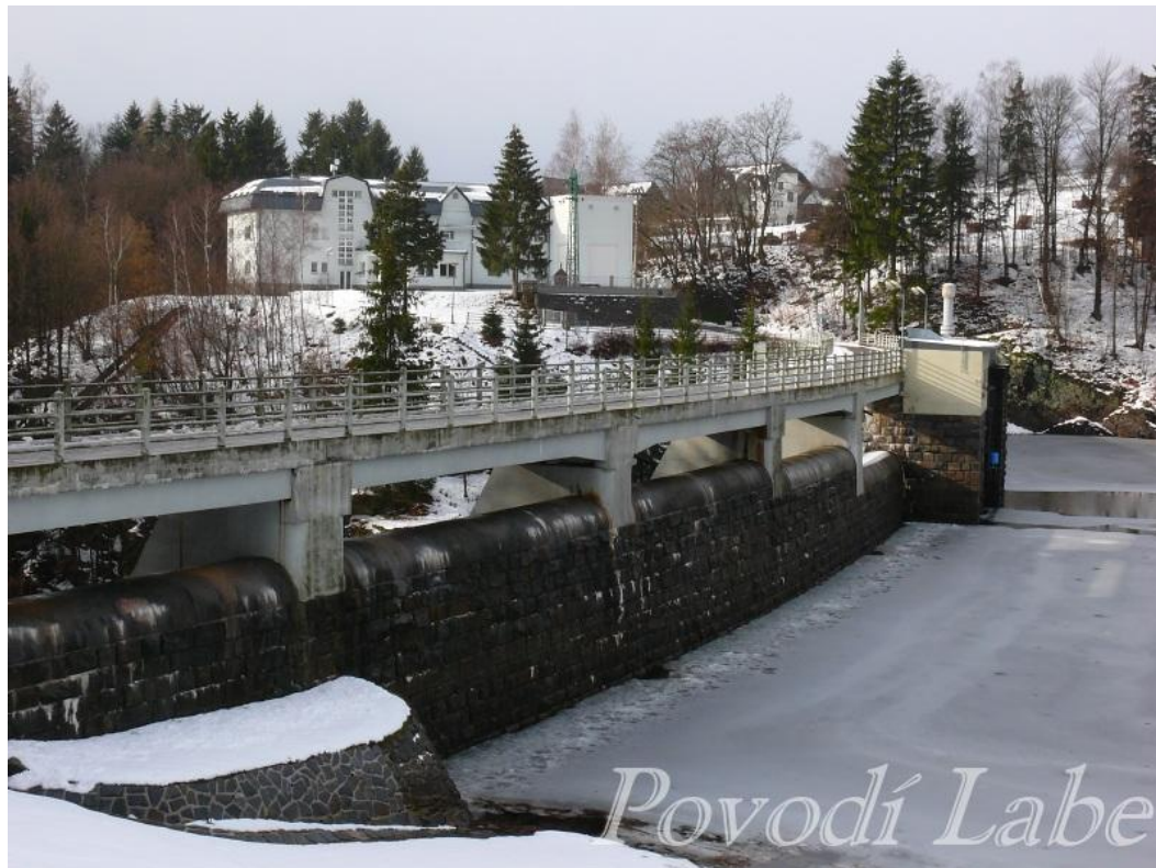
Příloha č. 11: Vodní dílo Pastviny, pohled na korunu hráze s přelivy
