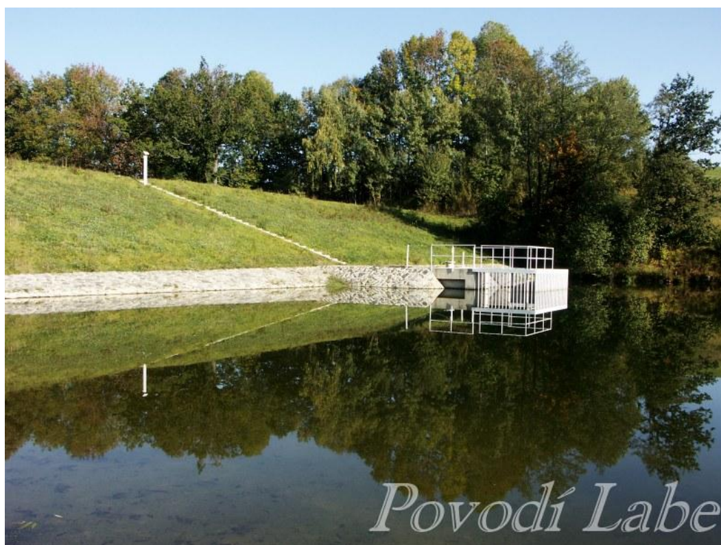
Příloha č. 9: Suchá nádrž č. 4 na Třebovce
