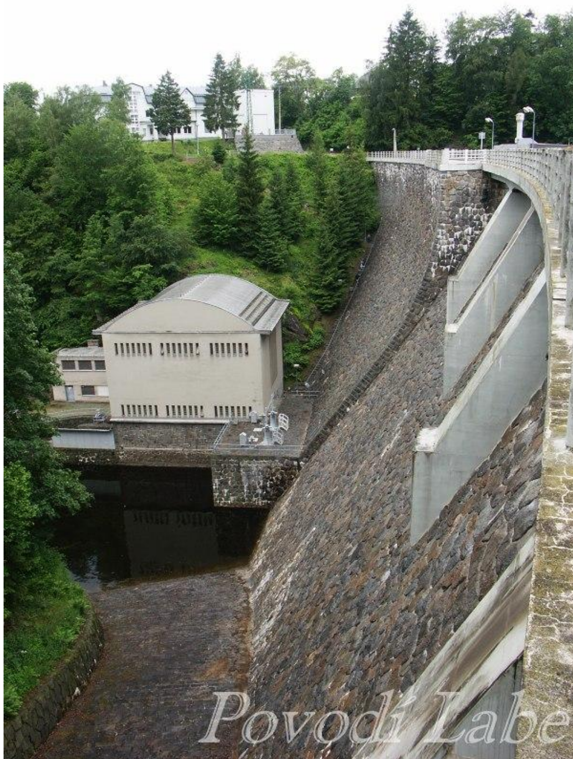
Příloha č. 12: Vodní dílo Pastviny, pohled na korunový přeliv, vzdušní líc a vodní elektrárnu
