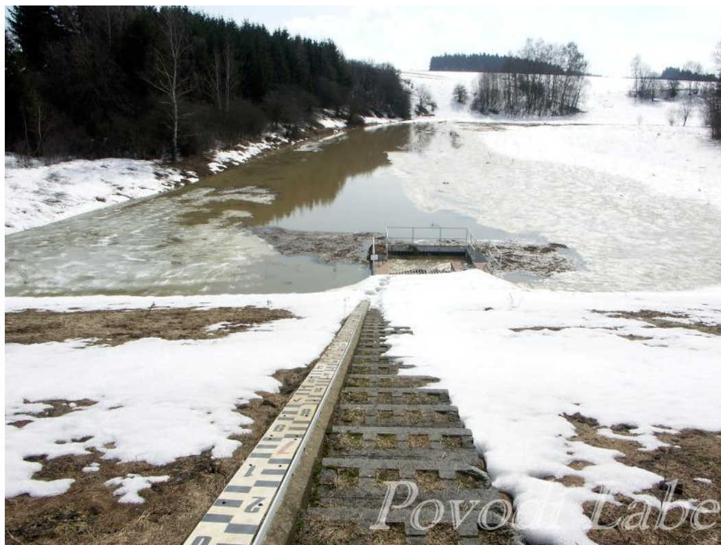
Příloha č. 8: Suchá nádrž č. 2 na Třebovce
