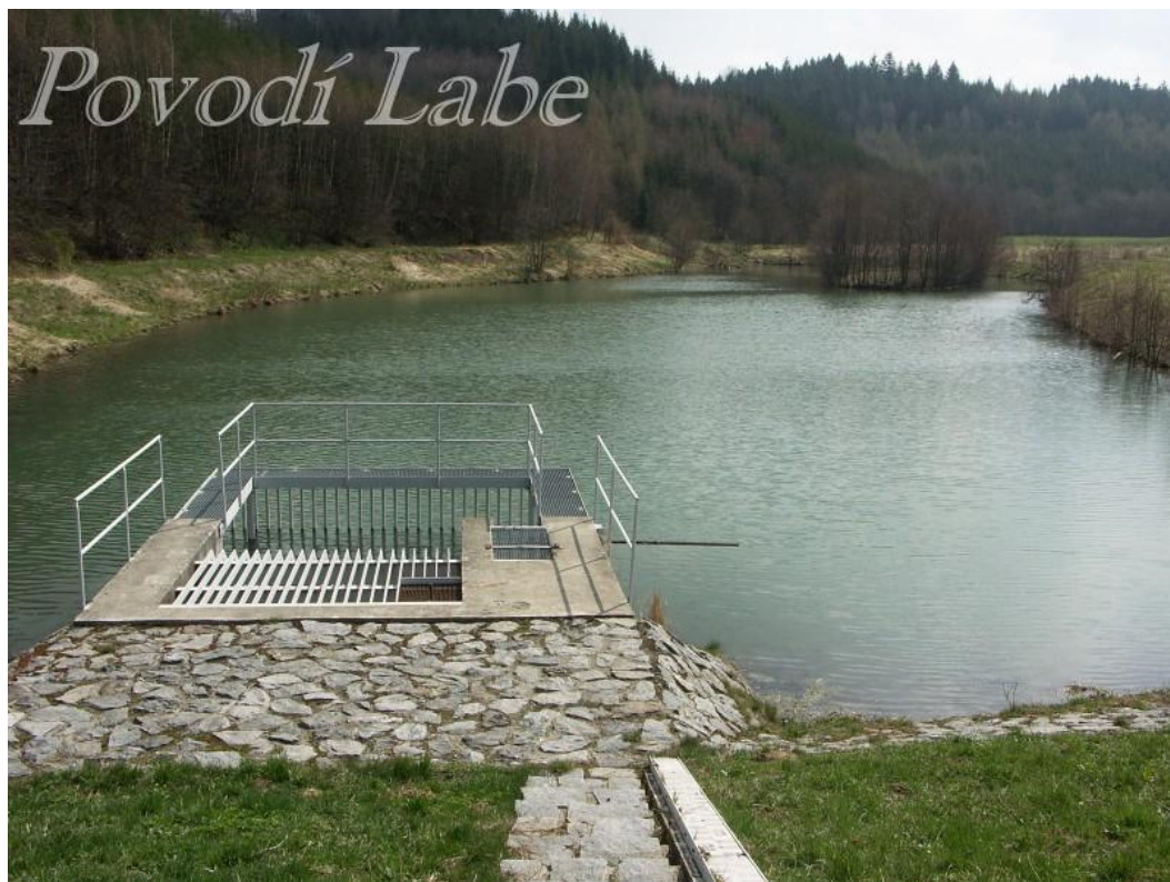
Příloha č. 10: Suchá nádrž č. 5 na Třebovce
