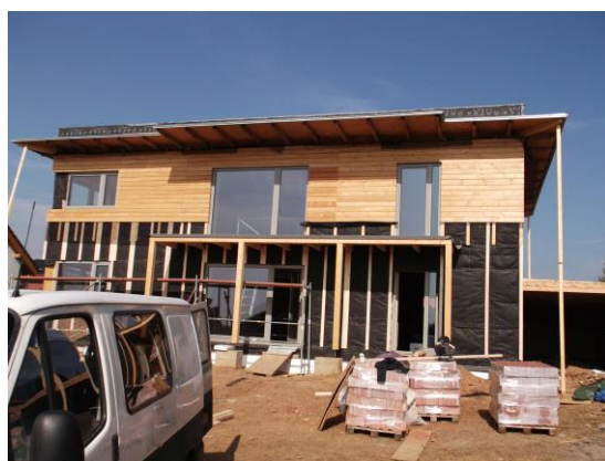
Obr. 10 Zakládání zatepleného domu
