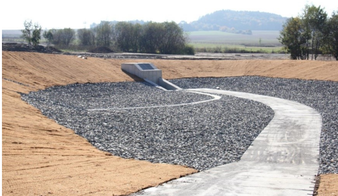
Obr. 3.1 Retenční přírodní nádrž ve fázi budování v jiné společnosti
