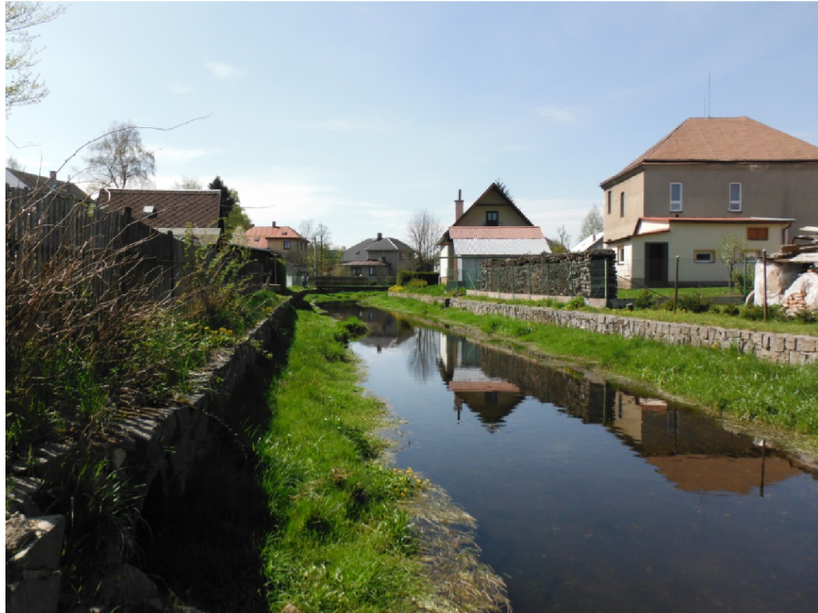
Obrázek 29: Zanesení koryta, pohled proti proudu, rok 2015 ř. km 166,879
