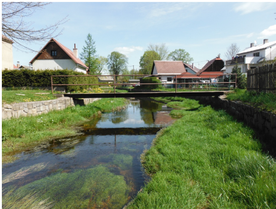
Obrázek 11: Lávka pro pěší - pohled po proudu, ř. km 166,953
