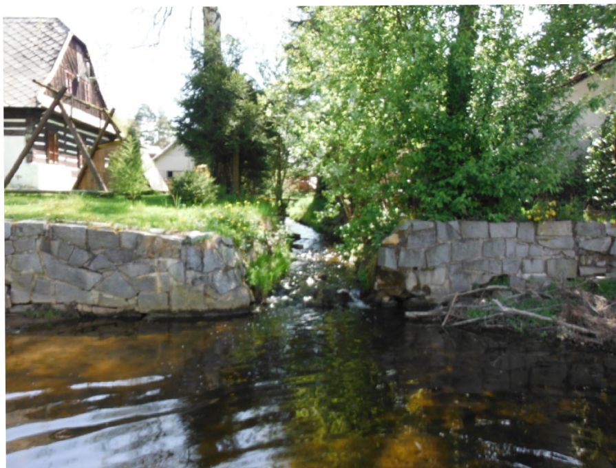
Obrázek 10: Pravobřežní přítok Brušoveckého potoka, ř. km 166,739
