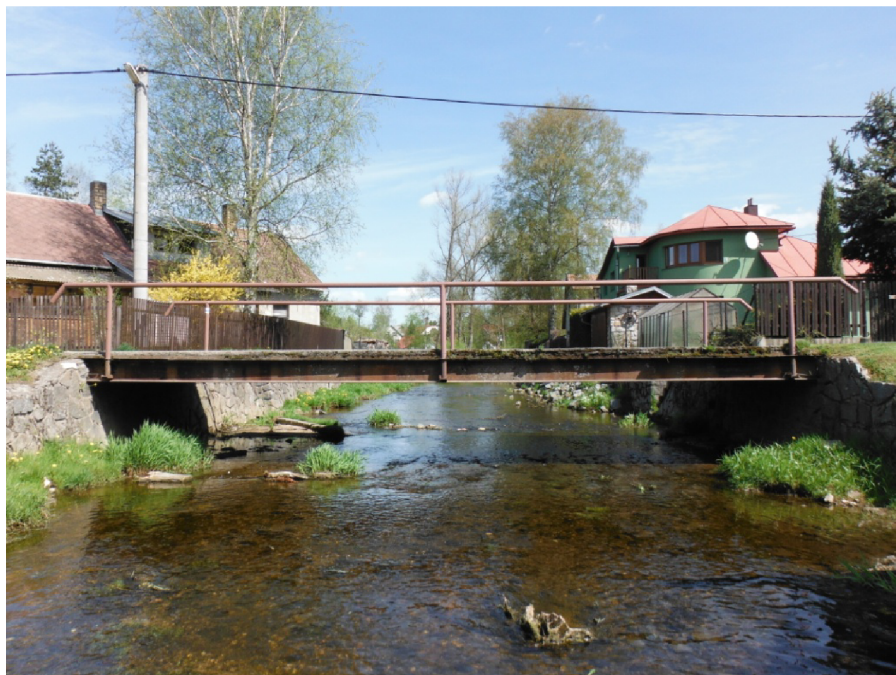
Obrázek 13: Lávka pro pěší - pohled po proudu, ř. km 166,651
