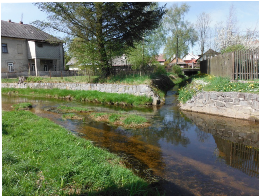
Obrázek 9: Levobřežní přítok potoka Ambrožka, ř. km 166,997
