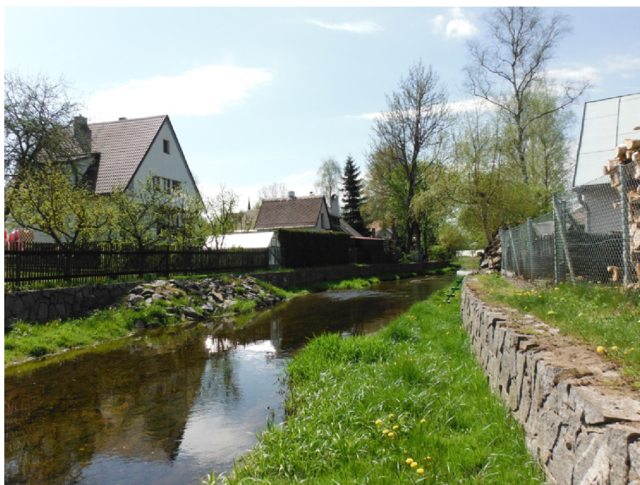
Obrázek 17: Oprava pravého břehu, pohled proti proudu, rok 2015, ř. km 166,678
