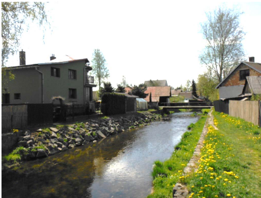
Obrázek 18: Oprava pravého břehu v roce 2015, pohled proti proudu, ř. km 166,607
