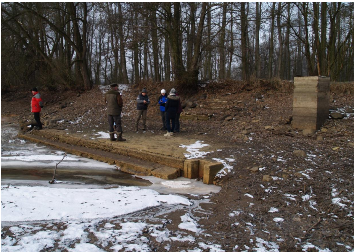
Pohled na vtok do spodní výpusti v lovišti, vtokový objekt bez česlové stěny
