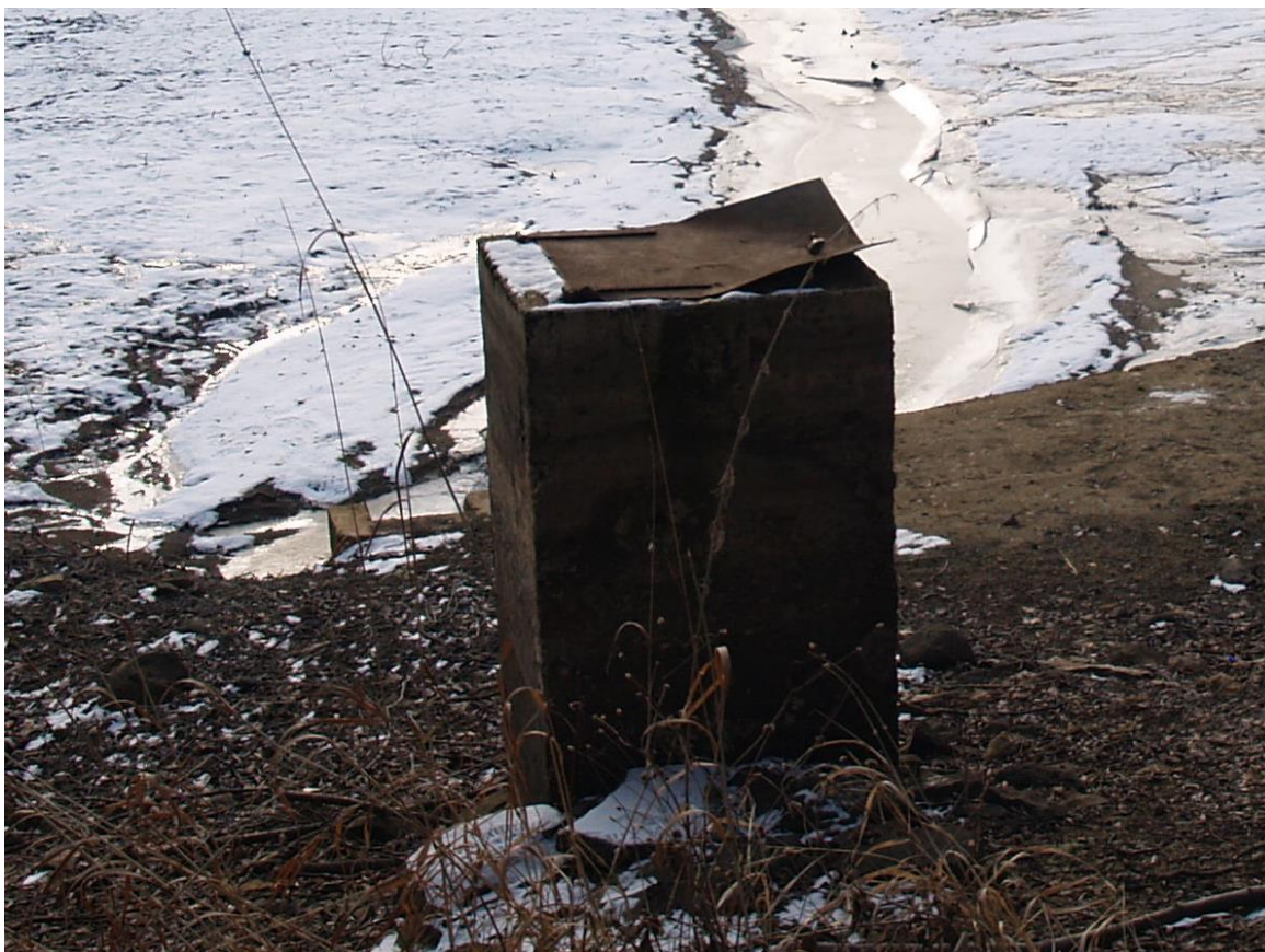
Šachta požeráku výpusti je opatřena poklopem proti neoprávněné manipulaci
