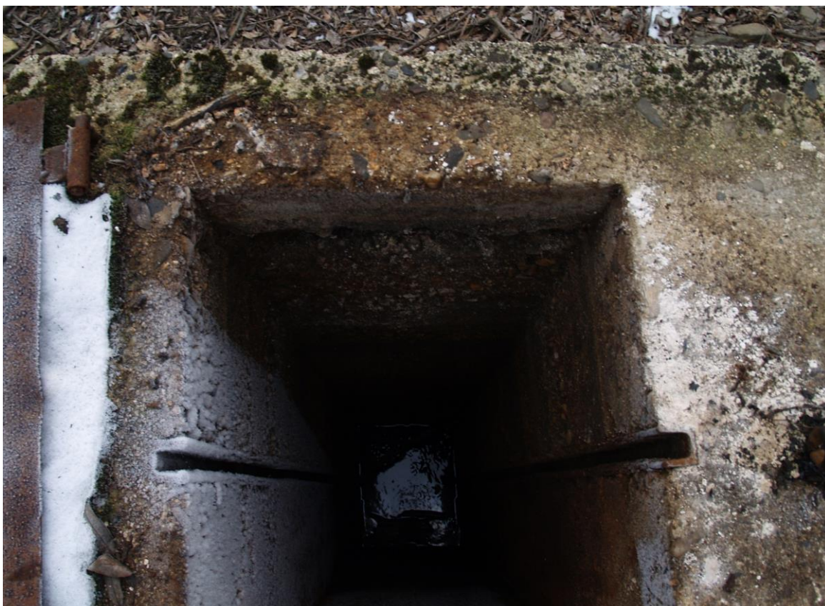
Pohled do šachty betonového, jednořadého, uzavřeného požeráku
