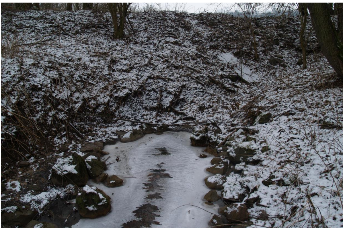
Pohled na potrubní jámu v podhráží. Vyústění potrubí
