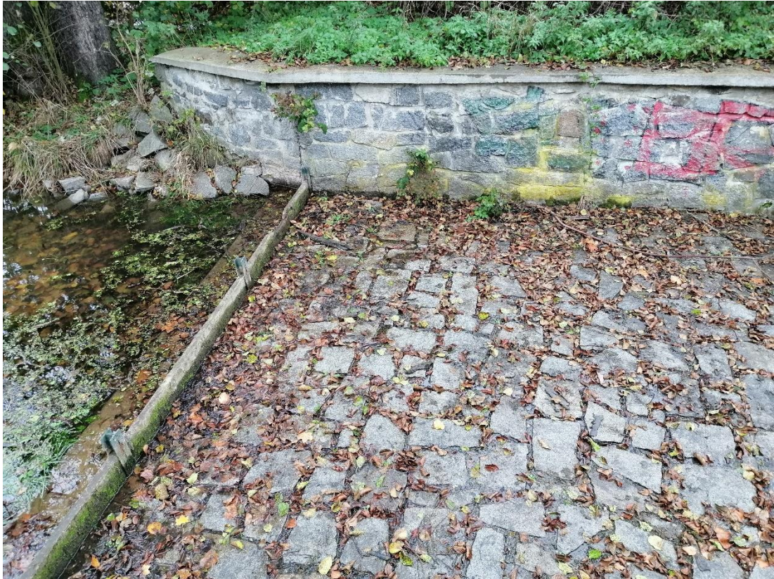
Obrázek č. 14 – Opraven bezpečnostní přeliv, fotografie pořízena k říjnu 2022 (Zdroj: Vlastní zpracování, 2022)
