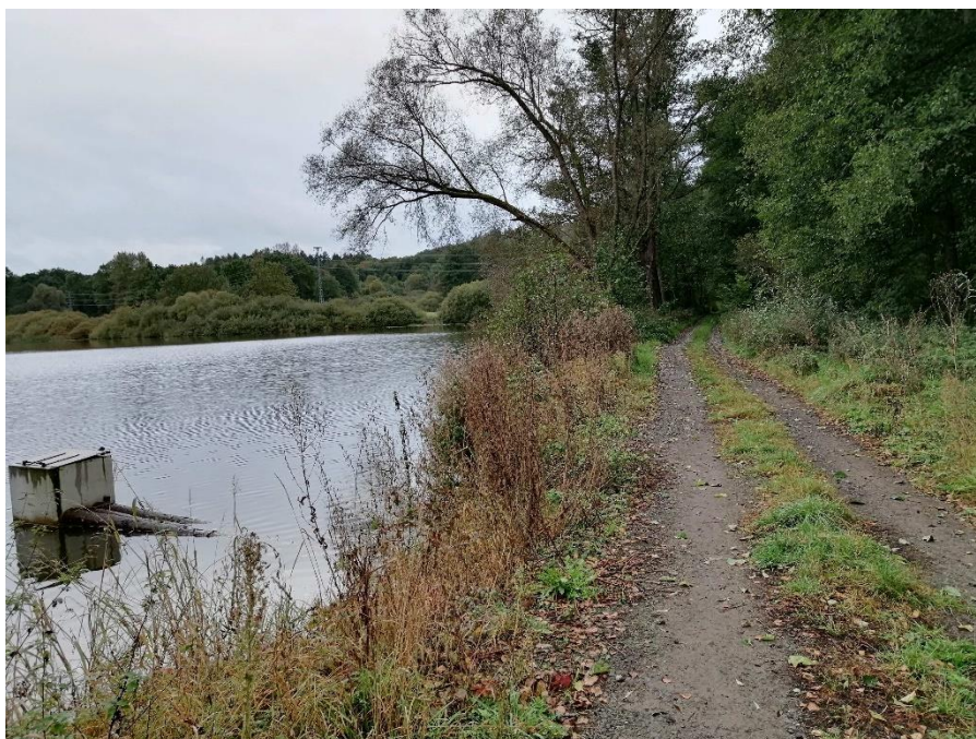
Obrázek č. 16 – Opravená spodní výpust, fotografie pořízena k říjnu 2022 (Zdroj: Vlastní zpracování, 2022)
