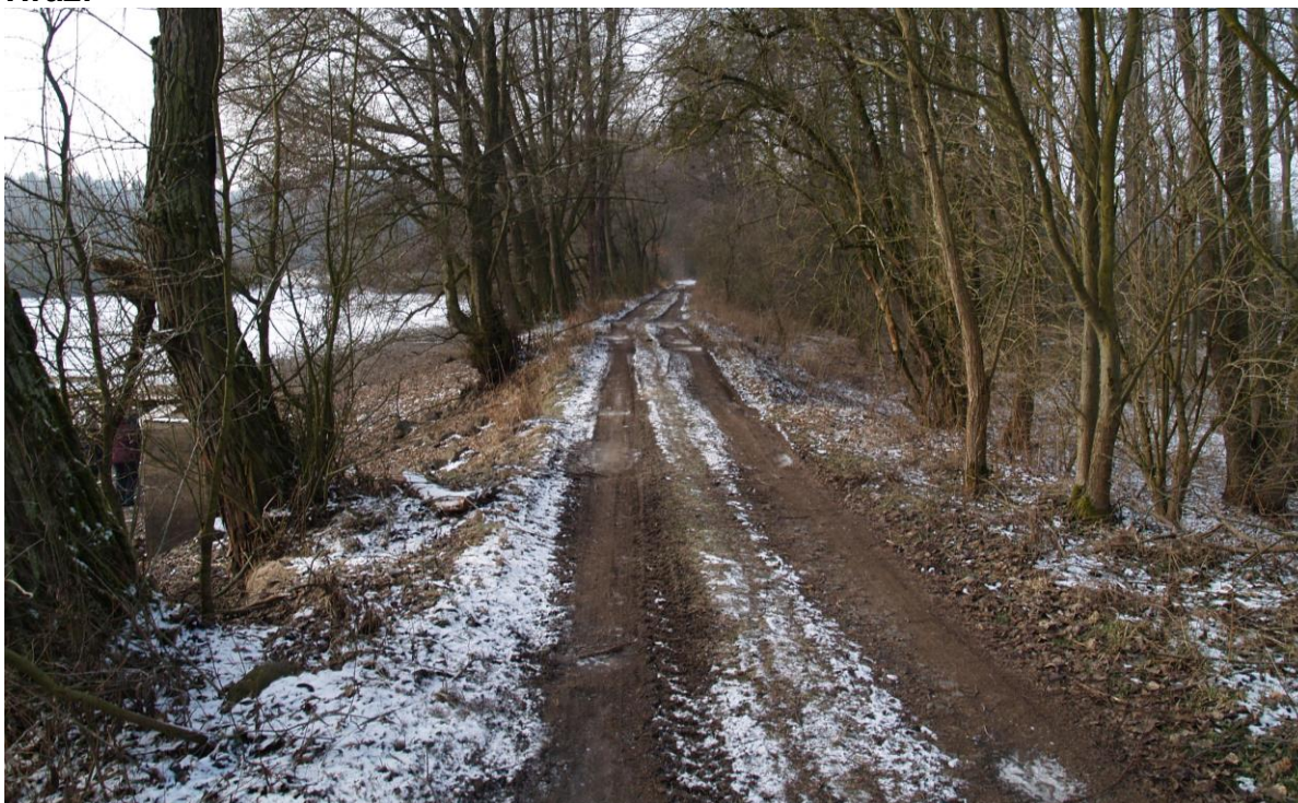
Koruna hráze: Pohled na urovnanou korunu hráze od pravého zavázání.
