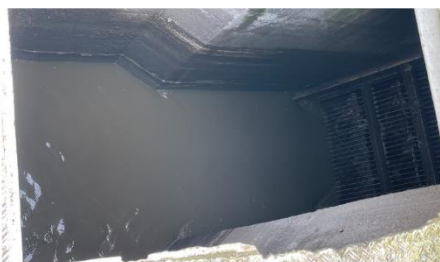
Přítok odpadních vod
