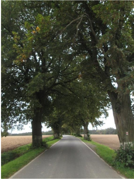
Obrázek 2 – Pohled na alej – stav silnice, (foto autorky, 2022)
