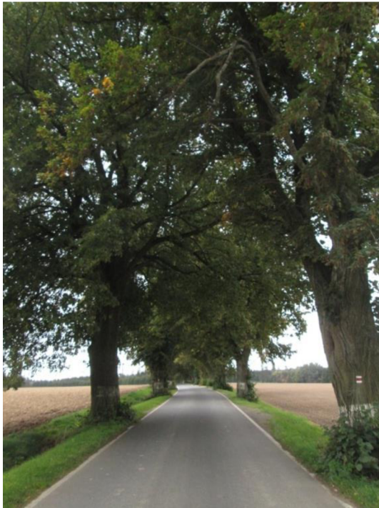
Obrázek 2 – Pohled na alej – stav silnice, (foto autorky, 2022)
