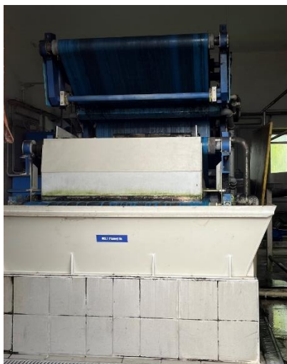
Obrázek 12: Kalolisa ČOV Šternberk
