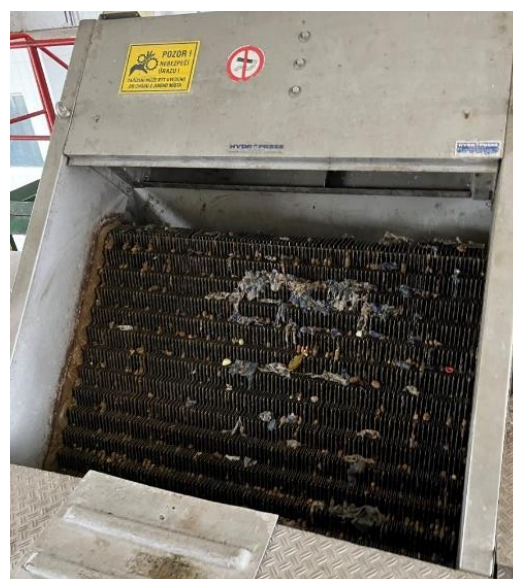
Obrázek 2: Jemné česle ČOV Olomouc Nové Sady
