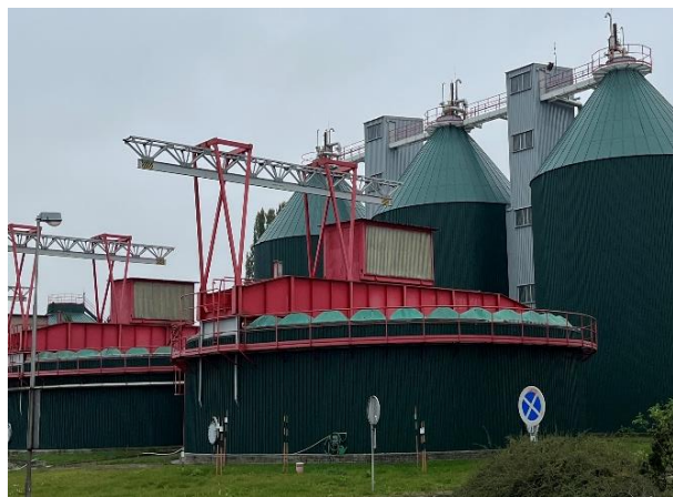
Obrázek 8: Vyhňivací nádrže ČOV Olomouc Nové Sady
