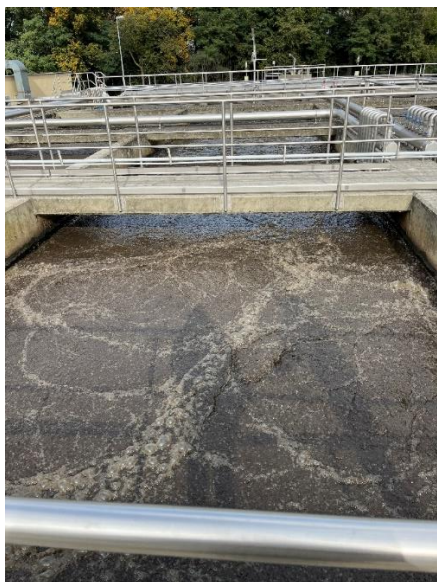
Obrázek 6: Aktivační nádrž ČOV Šternberk
