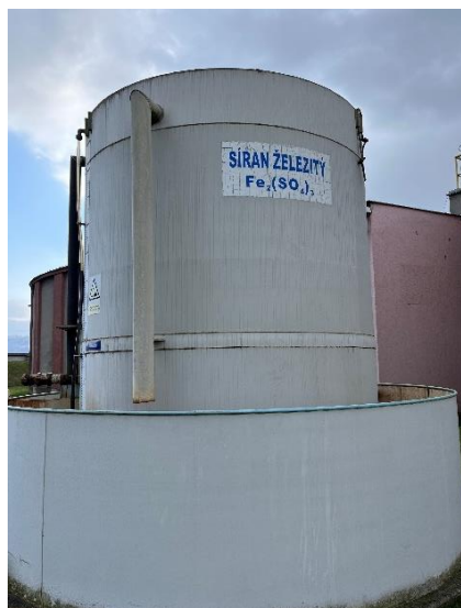
Obrázek 10: Zásobník síranu ČOV Šternberk
