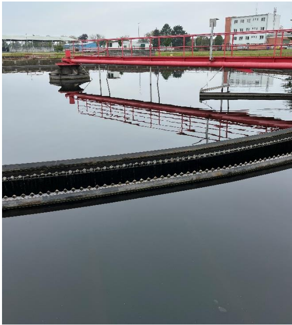
Obrázek 14: Dosazovací nádrž ČOV Olomouc Nové Sady
