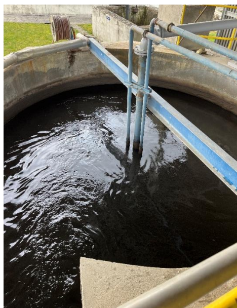
Obrázek 4: Lapák pisku ČOV Šternberk
