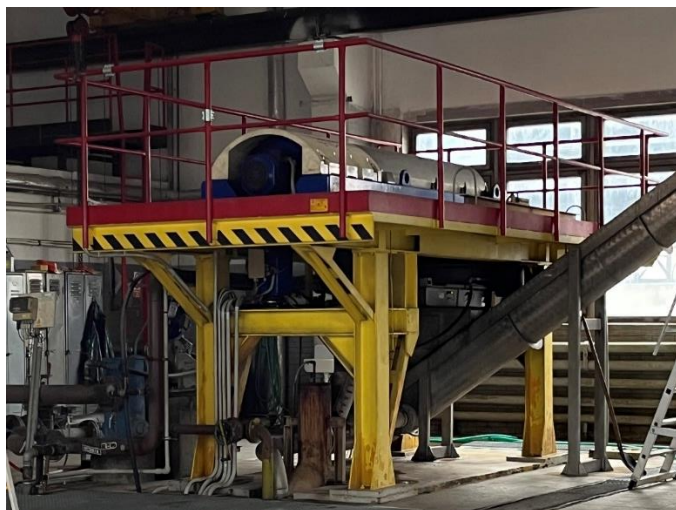
Obrázek 13: Odstředivka ČOV Olomouc Nové Sady
