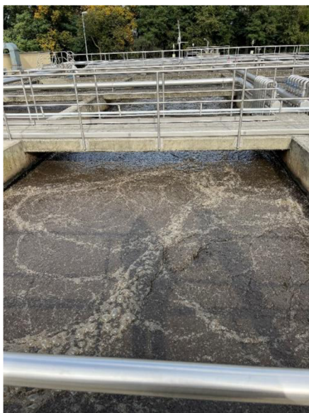
Obrázek 6: Aktivační nádrž ČOV Šternberk
