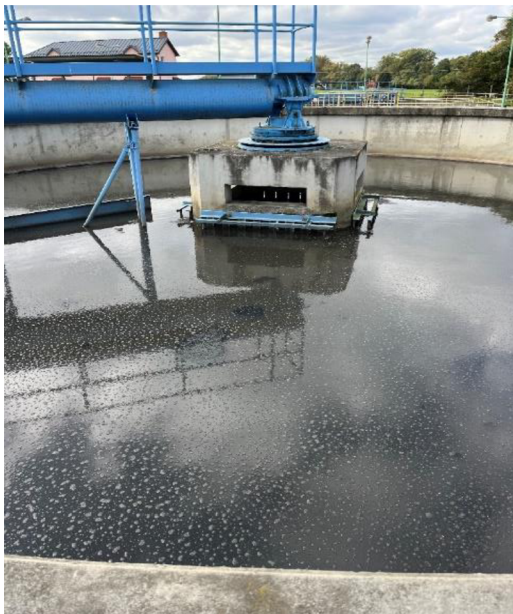
Obrázek 5: Usazovací nádrž ČOV Šternberk
