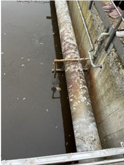
Obrázek 9: Dávkovač síranu ČOV Olomouc Nové Sady
