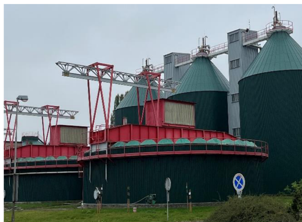
Obrázek 8: Vyhňivací nádrže ČOV Olomouc Nové Sady
