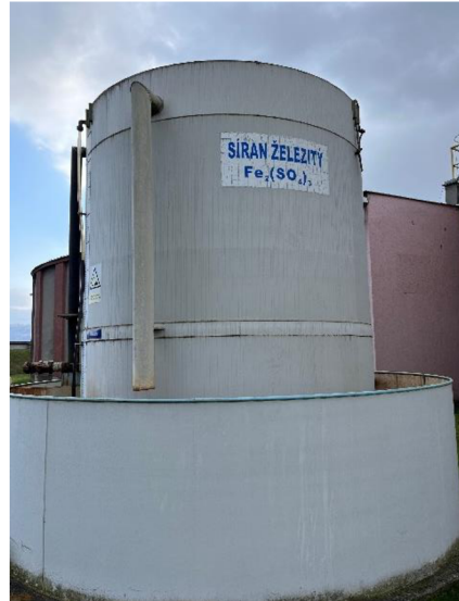
Obrázek 10: Zásobník síranu ČOV Šternberk
