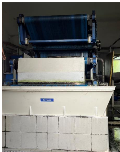
Obrázek 12: Kalolisa ČOV Šternberk
