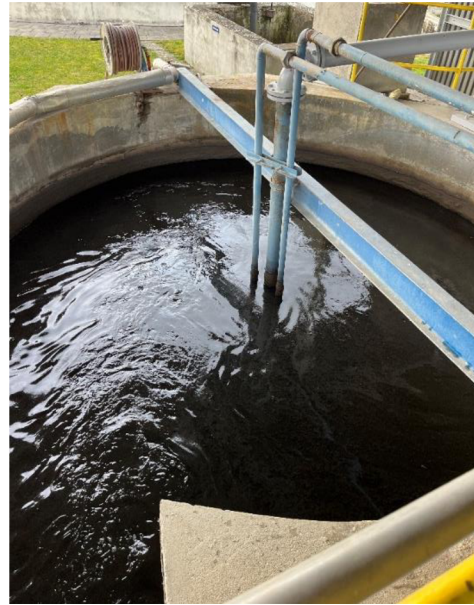
Obrázek 4: Lapák pisku ČOV Šternberk
