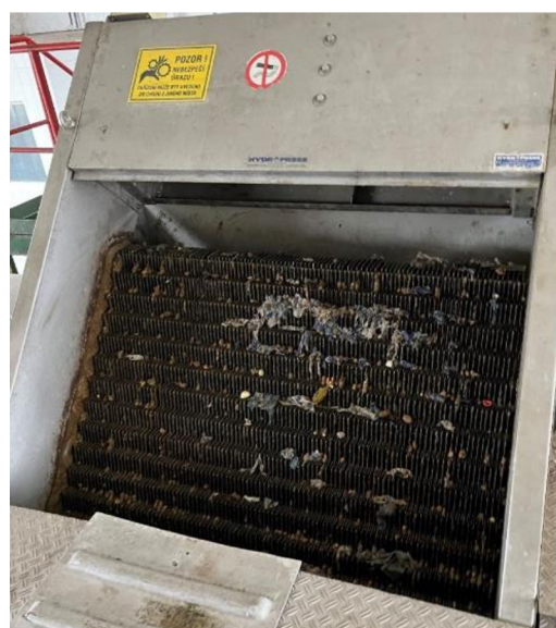
Obrázek 2: Jemné česle ČOV Olomouc Nové Sady
