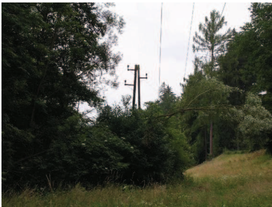
Obr. 1. Vznik zemního spojení pádem stromu do vedení
