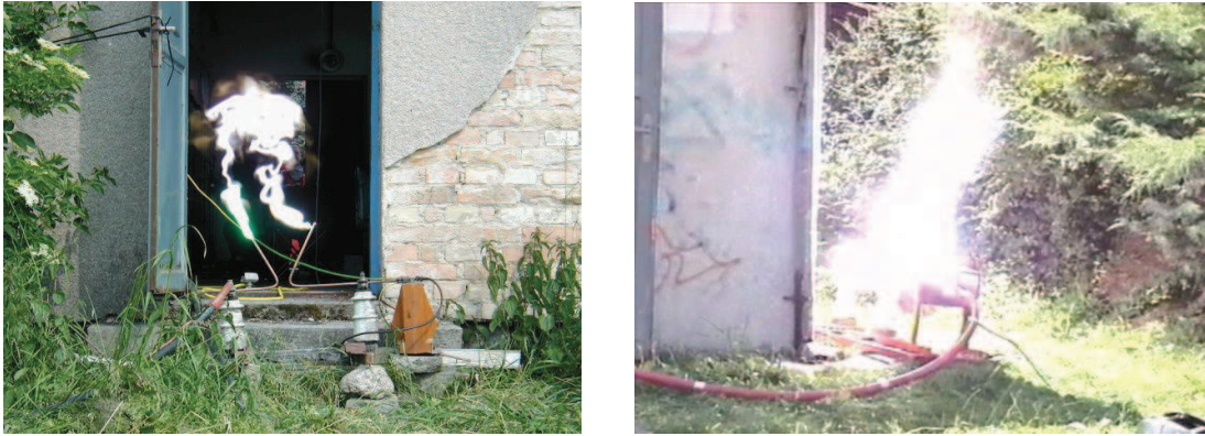
Obr. 3. Experimentální obloukové zemní spojení ve vzduchu a v kabelu
