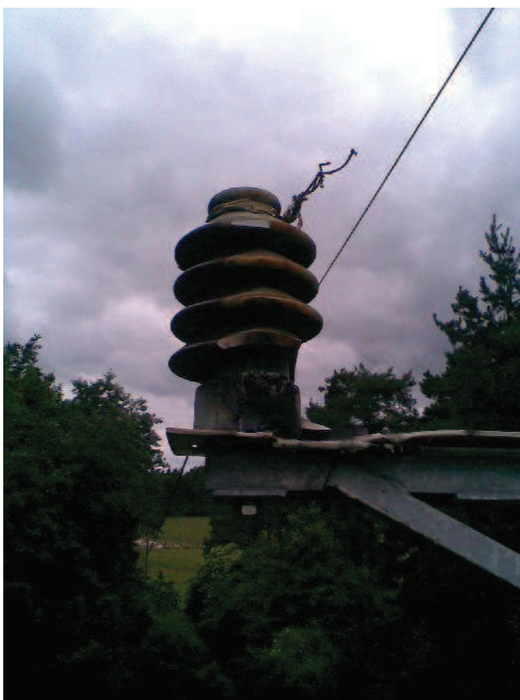
Obr. 2. Přetržení úchyty lana, důsledky zemního spojení přes konzolu a sloup
