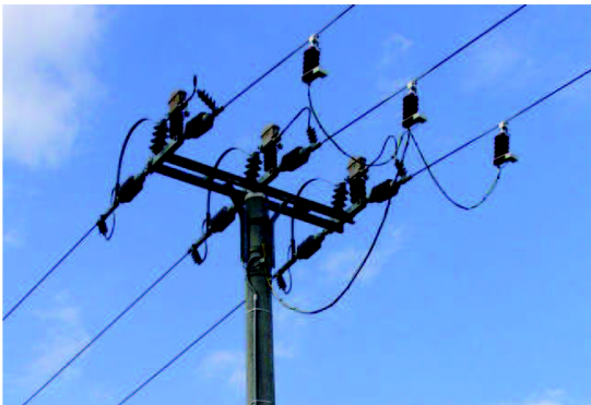
Obr. 49. Propojení snímačů zemnicím lanem.
