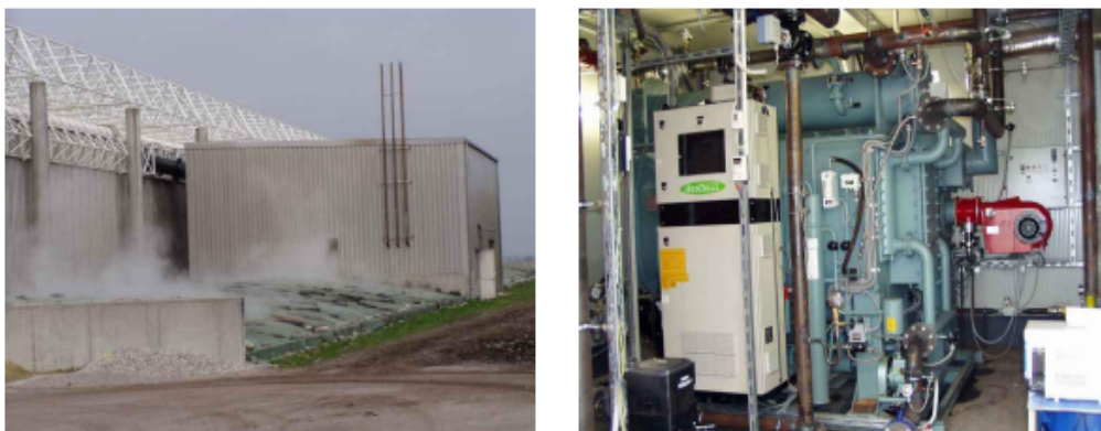
Obrázek 28 Hala kompostárny (vlevo); Absorpční TČ kompostárny [27]
