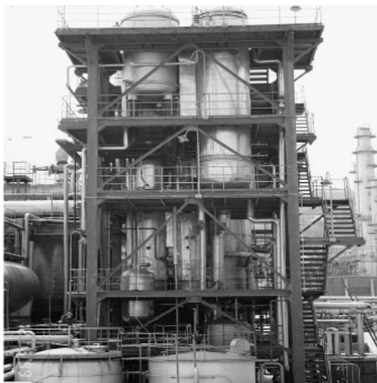
Obrázek 25 Absorpční tepelné čerpadlo v závodě na výrobu kaučuku [38]
