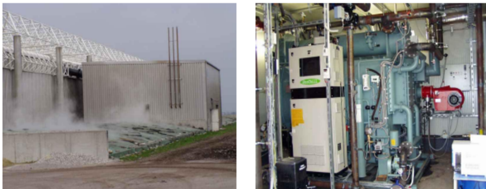
Obrázek 28 Hala kompostárny (vlevo); Absorpční TČ kompostárny [27]
