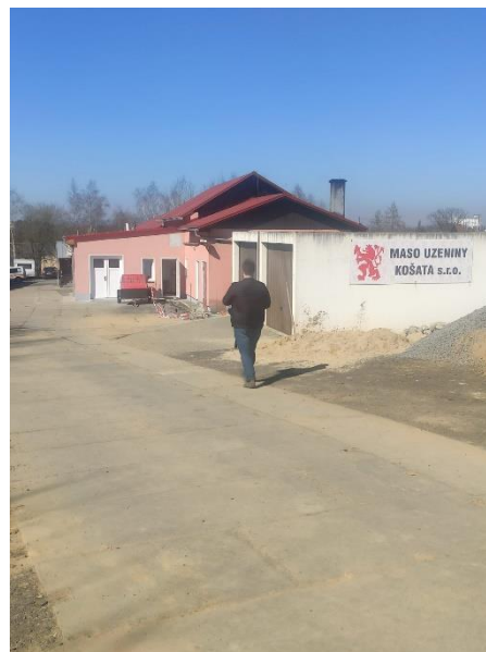
Obrázek 35- Exteriér masny Maso - uzeniny Košata s.r.o. Zdroj: vlastní (2022)
