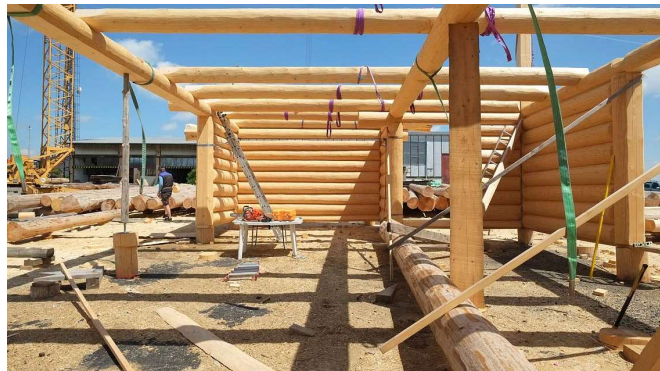
Obrázek 3 – Výstavba srubového objektu 17
