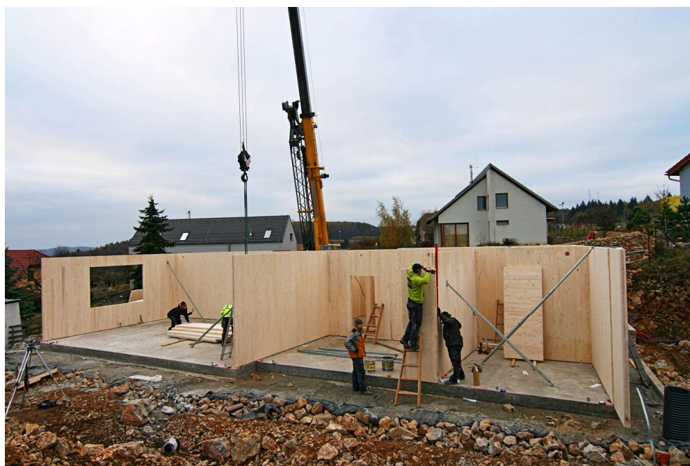
Obrázek 7 - Montáž CLT panelové konstrukce 34
