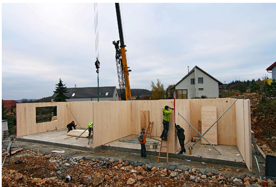
Obrázek 7 - Montáž CLT panelové konstrukce 34
