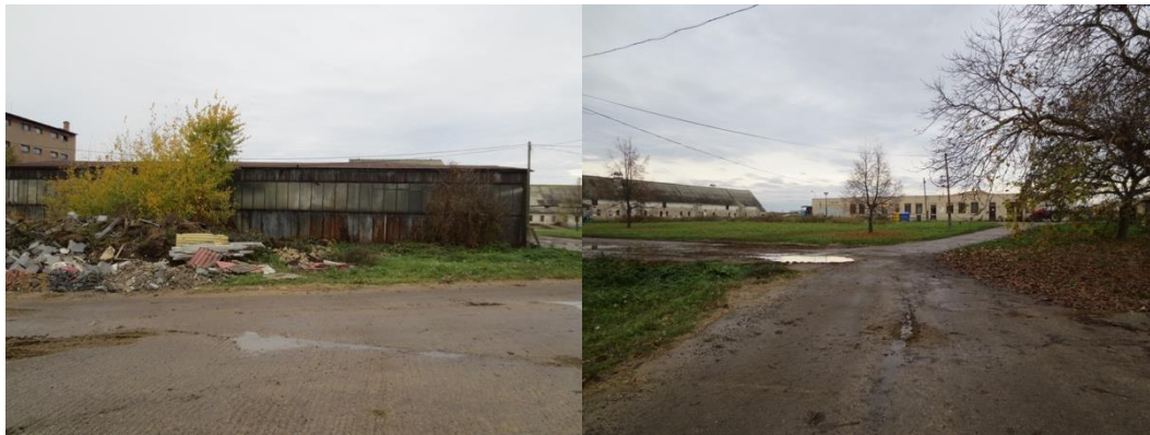
Obrázek č. 2 - Nový statek před rekonstrukcí
