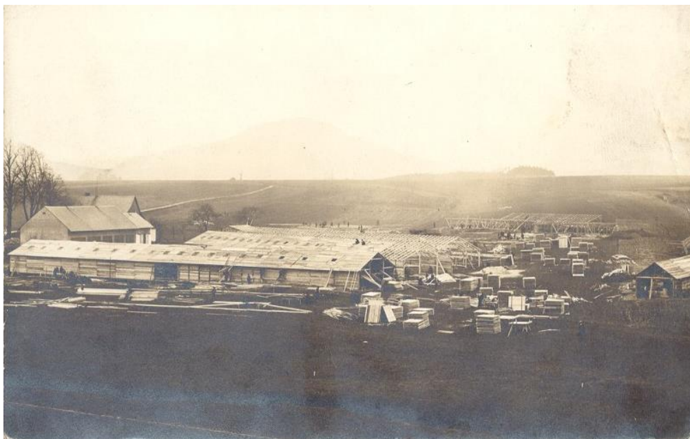
Obr. 1. Fotografie pořízená v počátcích výstavby tábora. Tábor je focen z jihovýchodu. Vpravo lze vidět zděné budovy hospodářského dvora Wenzela Schichta. Městský úřad Jablonné v Podještědí, zajatecký hřbitov (CD).
