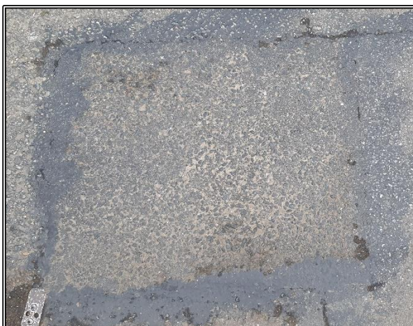
Obrázek č. 4: Vysprávka – aktuální stav, 16. 12. 2020
