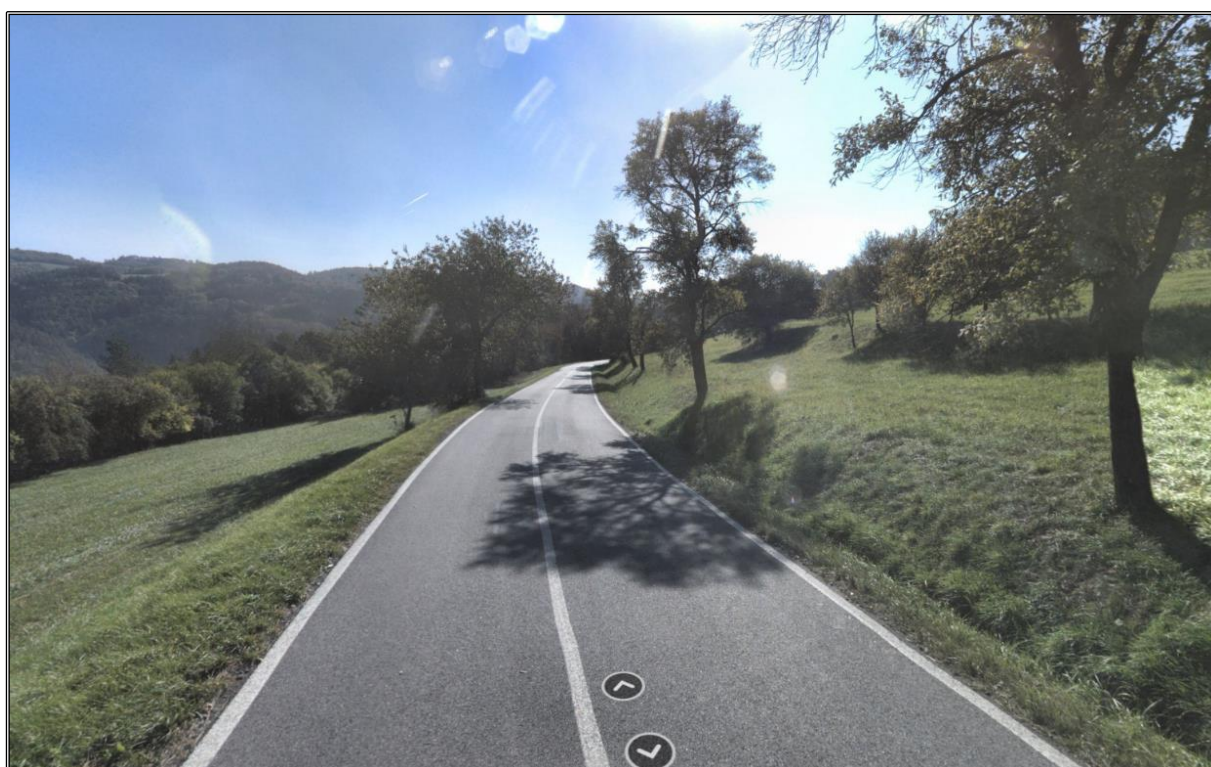
Obrázek č. 30: Silnice II/390 po pokládce nové obrusné vrstvy v roce 2013 – foto 2018 [55]
