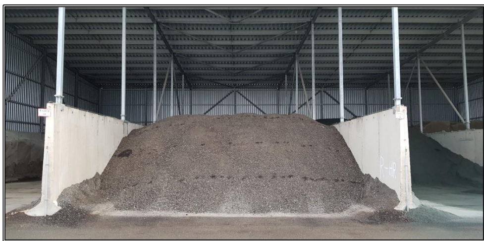
Obrázek č. 6: Zastřešená skládka R-materiálu na obalovně asfaltových směsí
