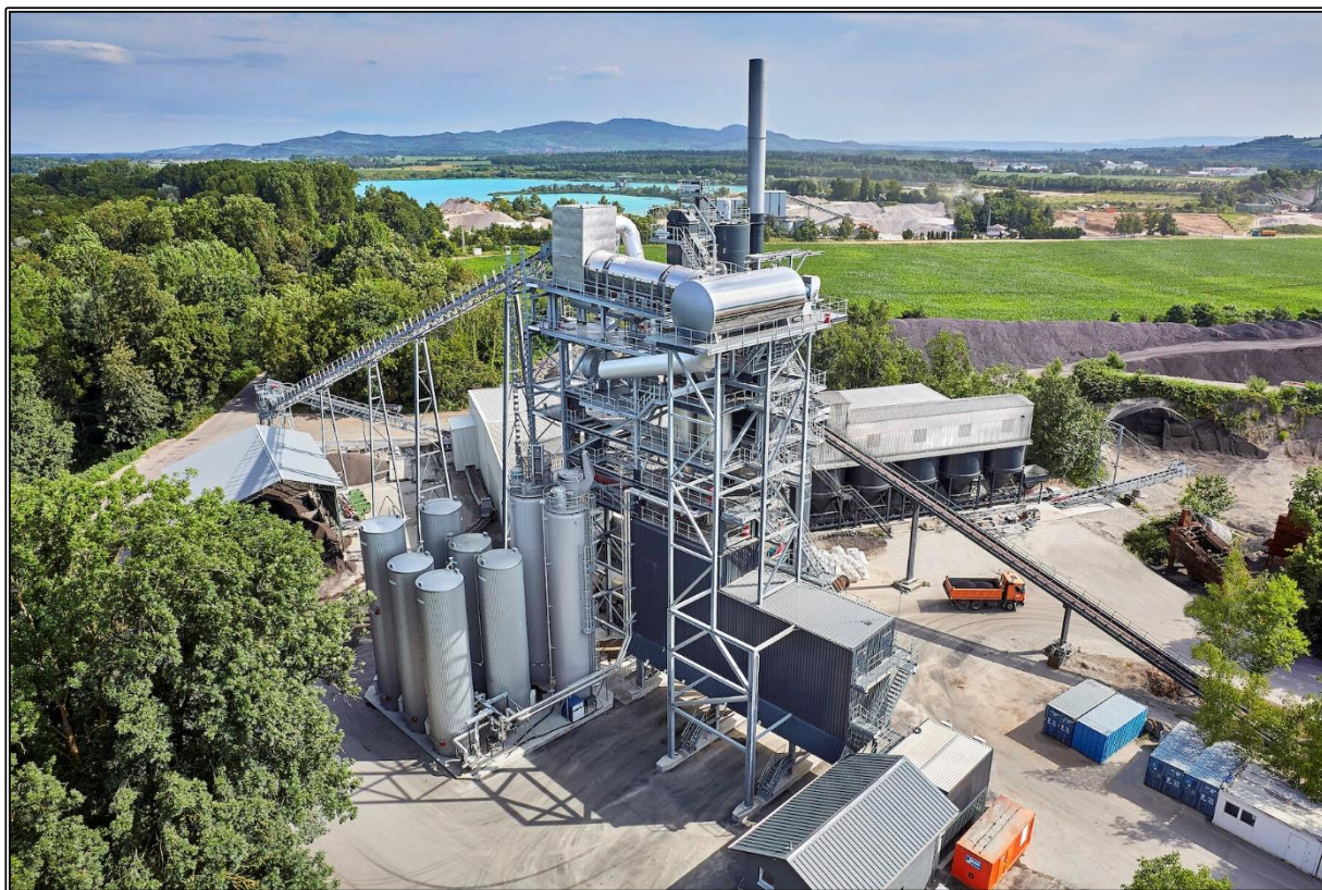
Obrázek č. 7: Obalovna asfaltových směsí s paralelním bubnem [11]
