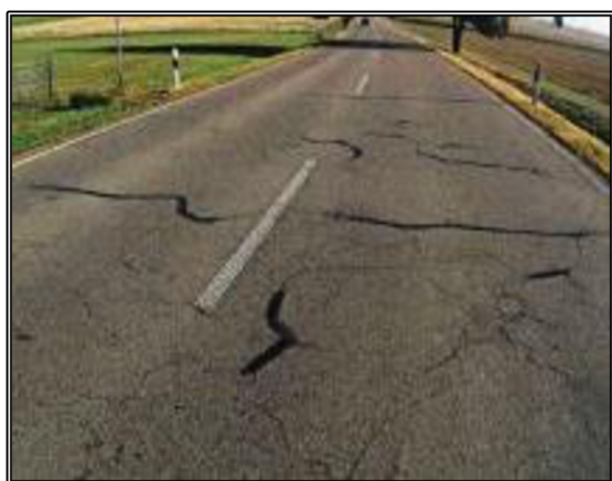
Obrázek č. 27: Vozovka s 85 % R-materiálu a rejuvenátorem Storbit Plus [14]
