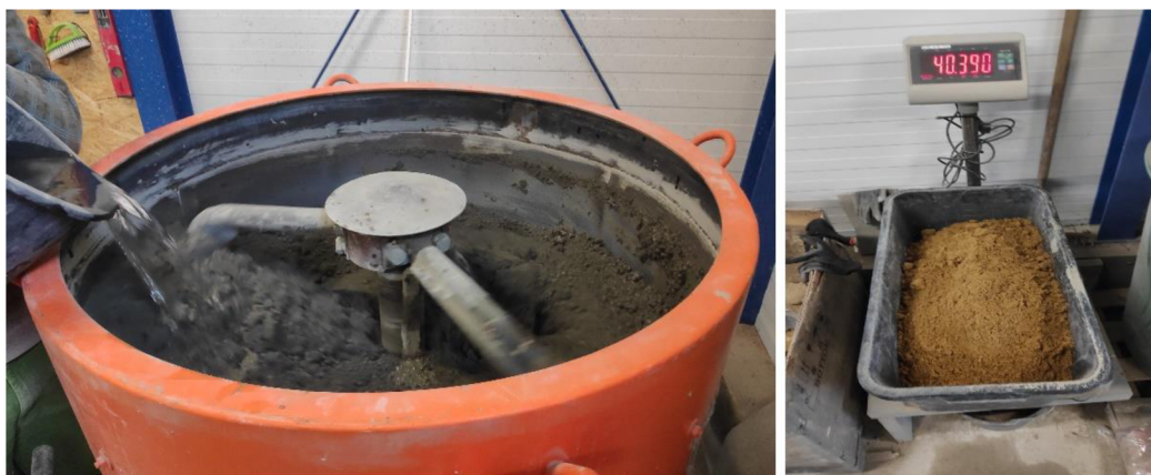
Obr. 13: Míchání čerstvého betonu a vážení složek betonu
