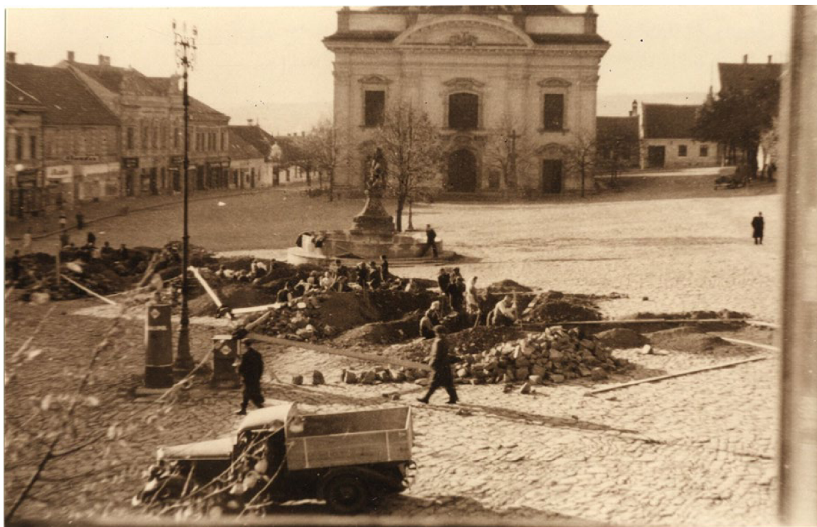
Příloha č. 6: Stavba protiletického krytu na Mariánském náměstí (za války Hitlerovo náměstí) v roce 1944
