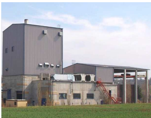
Obr. č. 5: Kotelna na biomasu
