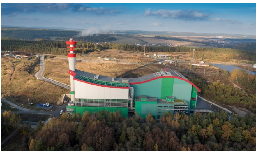
Obr. 4.28 Zařízení na energetické využití odpadu v Plzni zasazené do krajiny.
