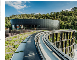
Obr. 39: Budova Butterfly, Praha/Kralín (zdroj viz kap. 9.1)
